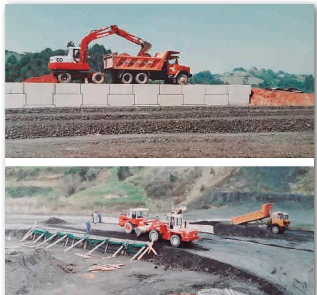
**Figura 3.** Terraplén de prueba utilizando dos sistemas de muros de tierra reforzada con elementos poliméricos y dos tipos de estériles (Pardo de Santayana *et al.*, 1994).
