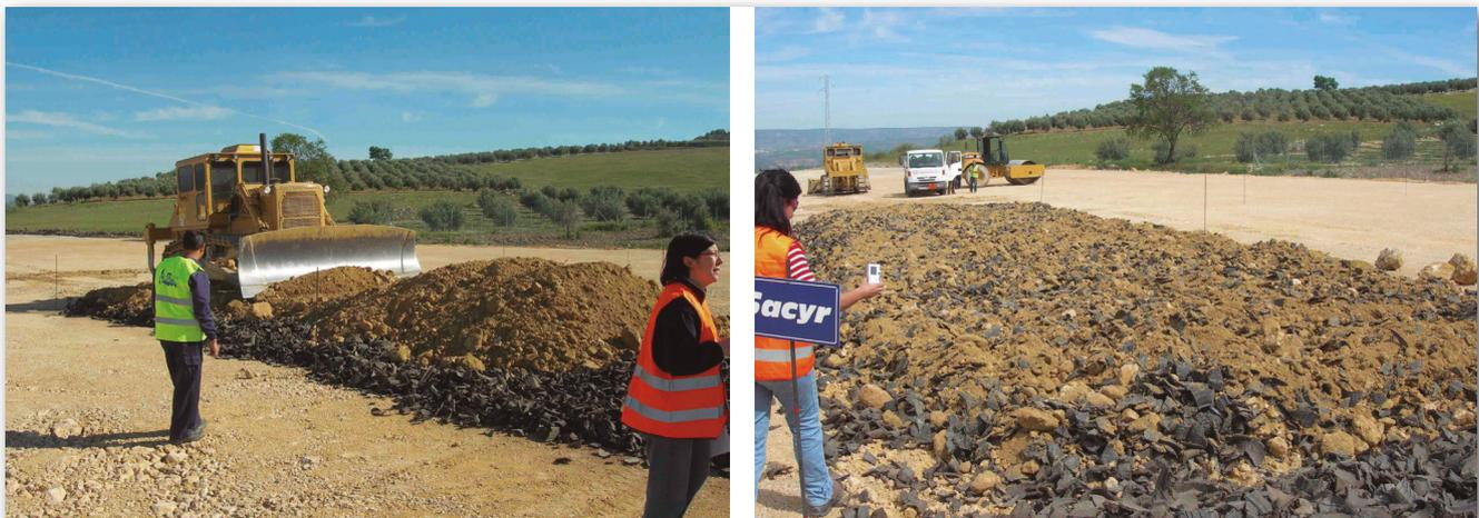
**Figura 12.** Ejecución de las bandas de prueba de NFUt mezclado con suelo.
