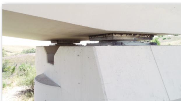
**Figura 5.** Detalle de apoyo en puente ferroviario. Fotografía realizada con dron.
