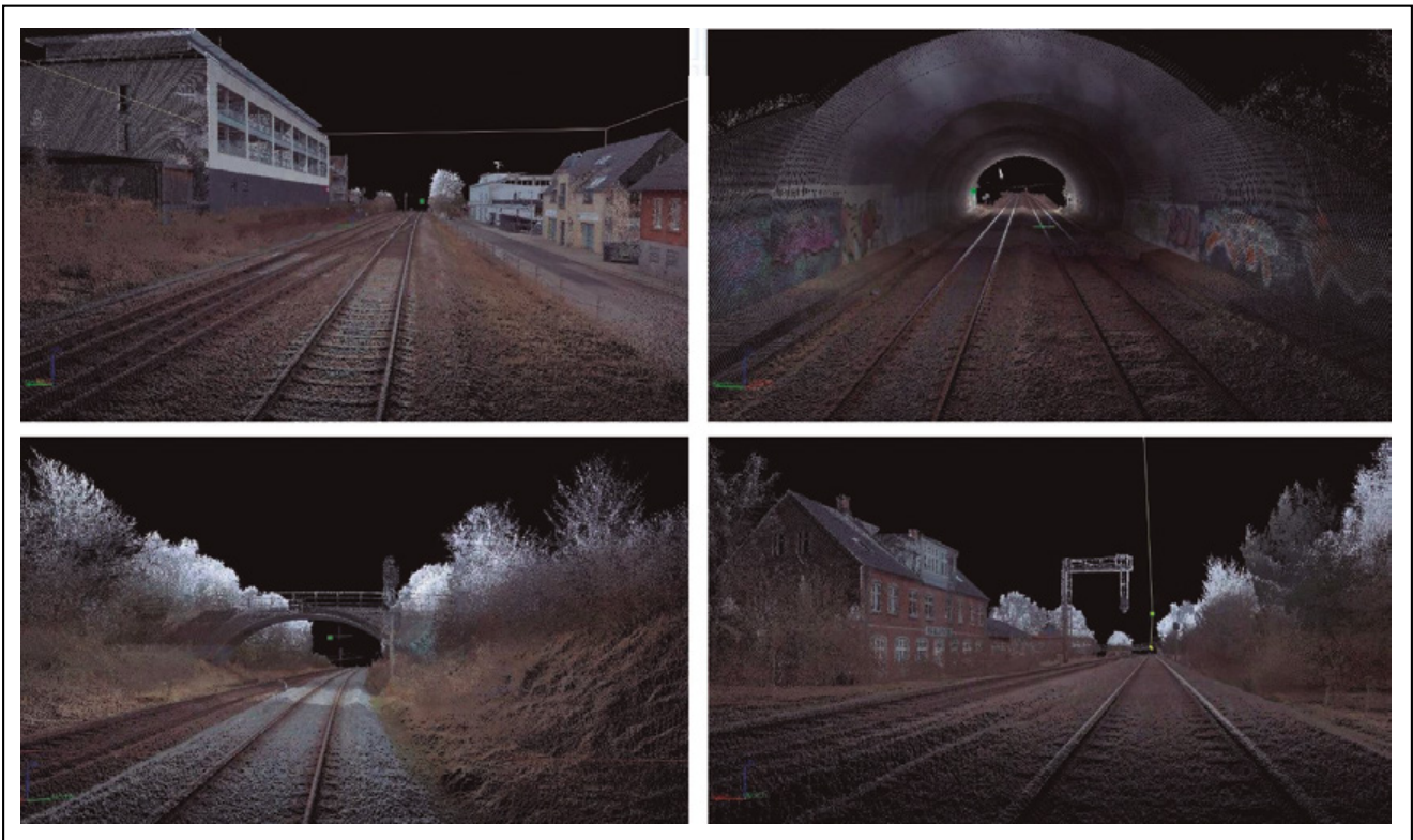
Figura 3. Reconstrucción por nubes de puntos mediante tecnología LiDAR (Fuente: TrimbleMX9).
