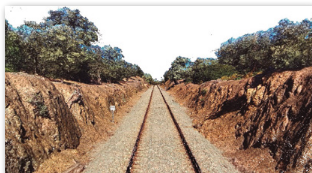
Figura 2a. Reconstrucción por nubes de puntos mediante procesado de imágenes en la línea Almorchón-Alhondiguilla en zona de trinchera.
