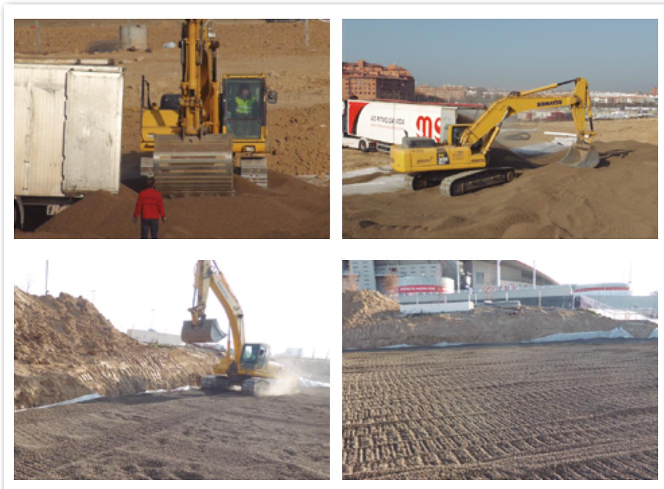
**Figura 16.** A) Suministro de arcilla expandida en camión de fondo móvil. B) Extendido del material con el cazo de la retro. C) Compactación del material con las cadenas de la retro. D) Aspecto de la arcilla expandida tras compactación. Todas las fotos de las obras de urbanización del exterior del Estadio Metropolitano de Madrid (2019).
