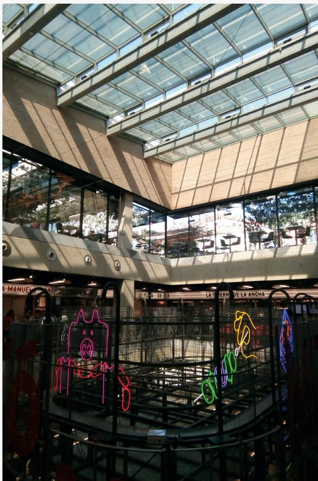
**Figura 2.** Cubierta acristalada fotovoltaica incluida en la rehabilitación en 2011 del mercado de San Antón, en Madrid. Arquitectos: Estudios ALTARIA, Módulos: Onyx Solar.
