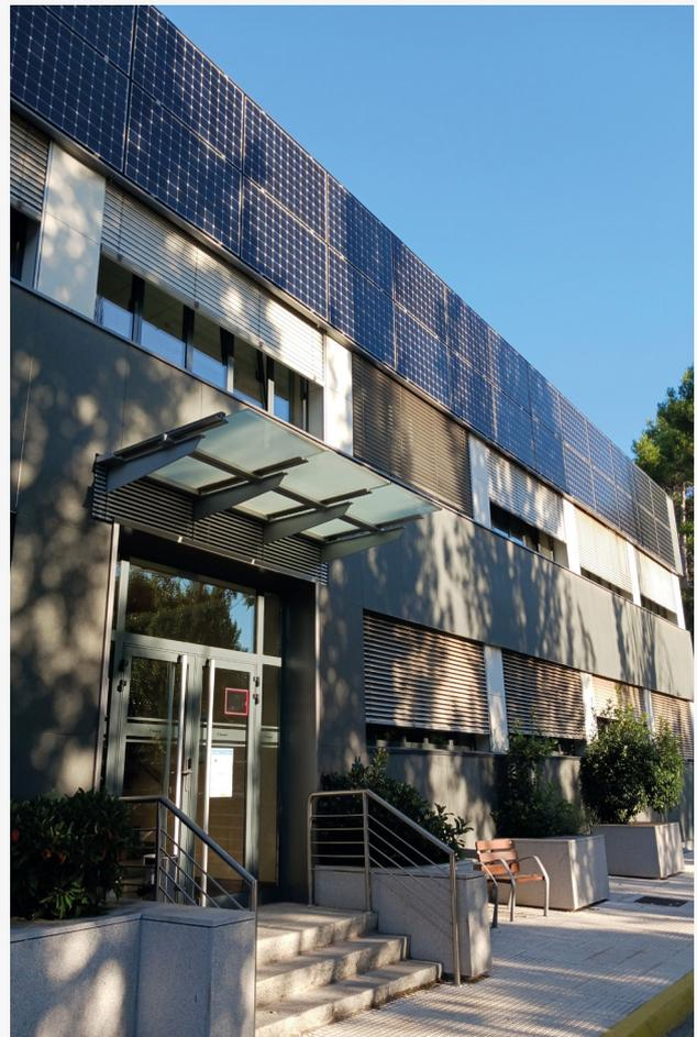
**Figura 3.** Integración de módulos fotovoltaicos en fachada ventilada. Rehabilitación energética en 2015 de la sede de la División de Energías Renovables del CIEMAT en Madrid. Arquitecto: Juan Carlos Gutiérrez. Módulos: Sunpower.
