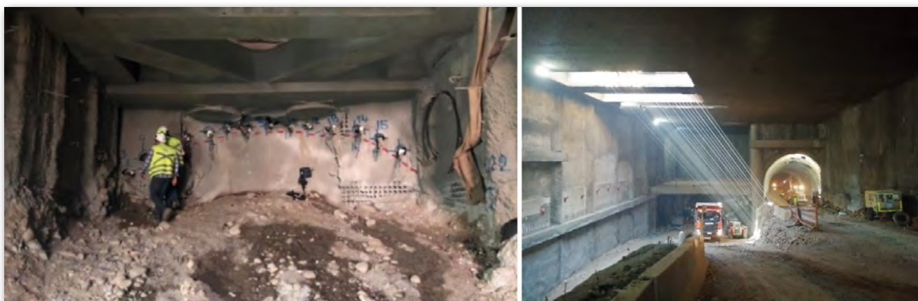
Figuras 38-39. Portal túnel en Mina. Ramal de acceso y Pozo 7+200.
