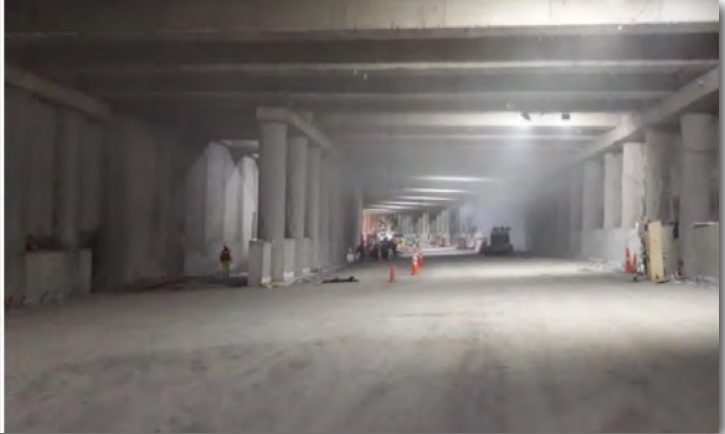
Figuras 32-33. Construcción del tramo en trinchera, falso túneles entre pantallas de pilotes.
