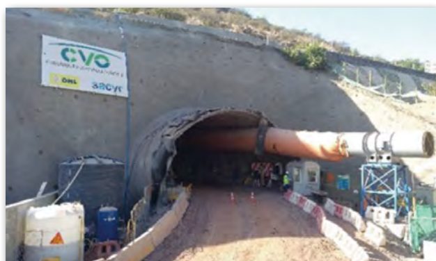
Figura 26. Portal norte del túnel de La Pirámide.
