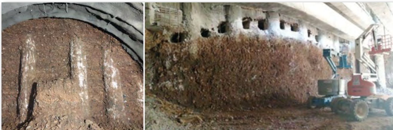
Figuras 36-37. Portales de túneles en mina: ramal e inicio de túnel híbrido.
