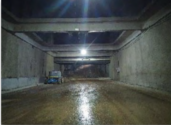
Figuras 32-33. Construcción del tramo en trinchera, falso túneles entre pantallas de pilotes.
