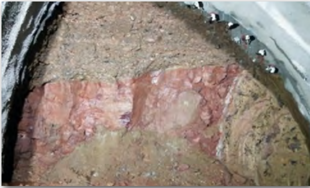
Figura 30. Frente mixto en el túnel de La Pirámide.
