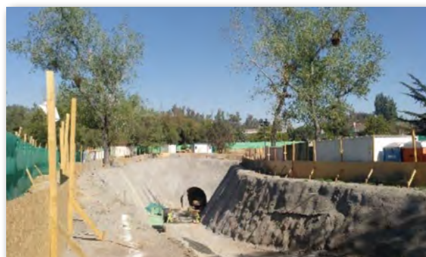
Figura 27. Portal galería de ataque sur.
