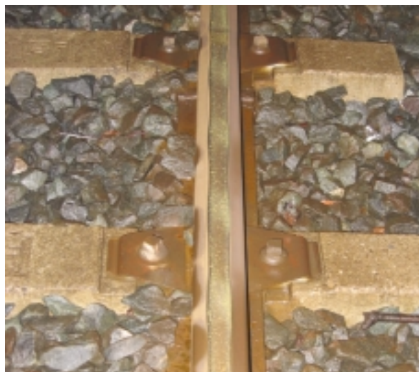
FIGURA 5. Rugosidad de carril: desgaste ondulatorio en línea de Metro.
