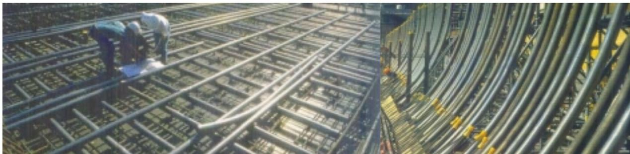
FIGURA 3. Instalación de armaduras pre-tensada en la barcaza Nkossa (12).
