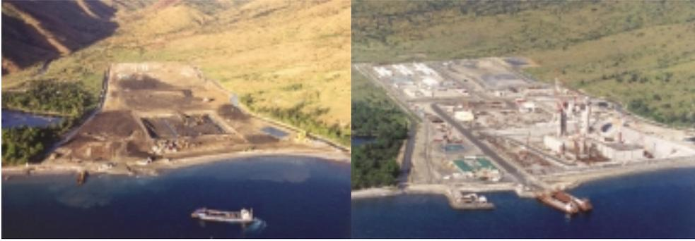
**FIGURA 4.** Dique en la costa de Nigeria para fabricar plataformas offshore de hormigón. En construcción y en operación (14).
