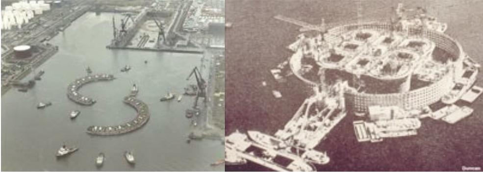
FIGURA 7. Rompeolas construidos por separado y en construcción rodeando la estructura.
