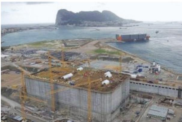
**FIGURA 2.** Construcción del cajón de hormigón de la terminal LNG "Adriatic" en Algeciras.
