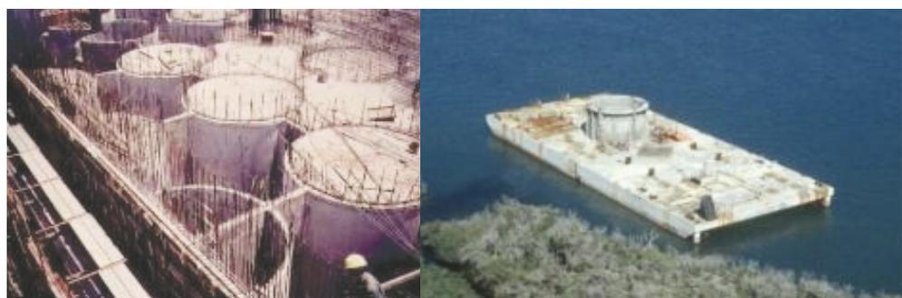
FIGURA 18. Barcaza Rofomex I: en construcción, con el sistema Honeycomb a la vista, y a flote (7).
