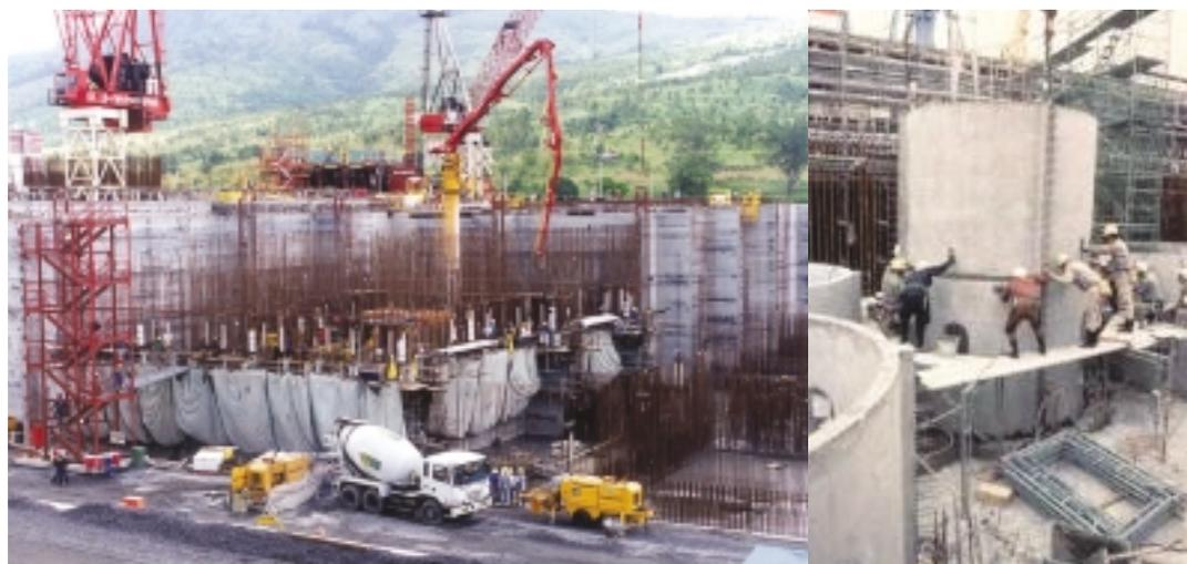
**FIGURA 5.** Actividades de construcción típicas de una plataforma offshore de hormigón: (14) y (16).
