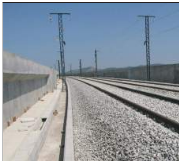
FIGURA 4. Interior del cajón del puente de hormigón.
