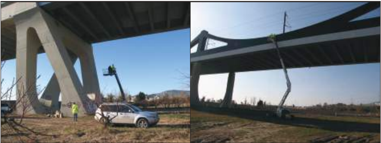
FIGURA 11. Utilización de medios auxiliares en el exterior de los viaductos.
