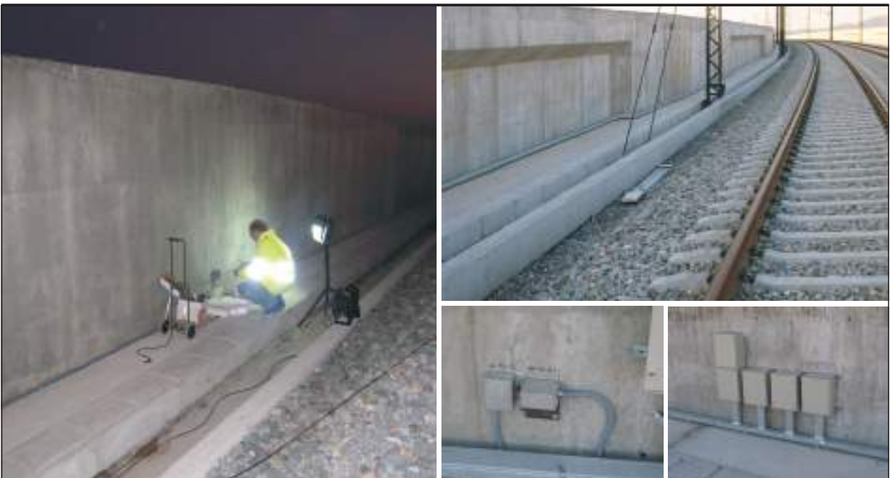
FIGURA 12. Trabajos nocturnos y detalles de acabado de puntos de medida, canalización y nodos.
