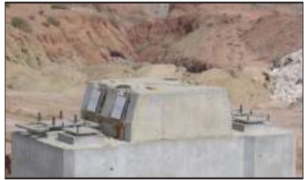
FIGURA 14. Machón de hormigón frente a sismo transversal en el viaducto de Salinetas (Foto Acciona).
