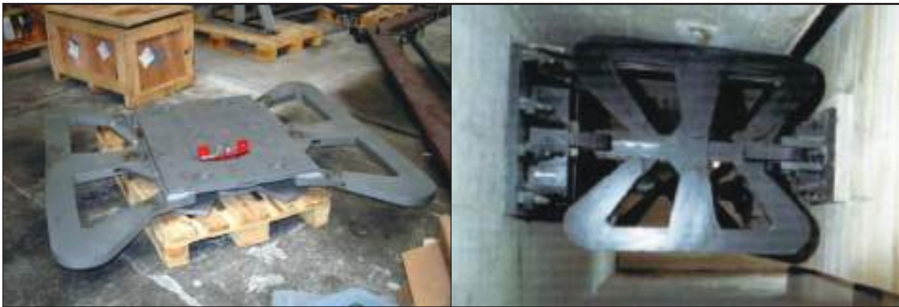
FIGURA 10. Disipadores elasto-plásticos en apoyo tipo POT guiado y en estribo (ATC-ALGA).
