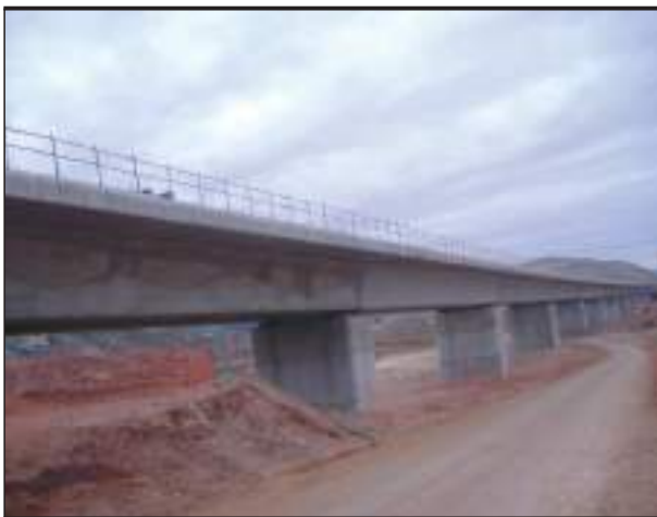
FIGURA 11. Vista general del viaducto de Salinetas.
