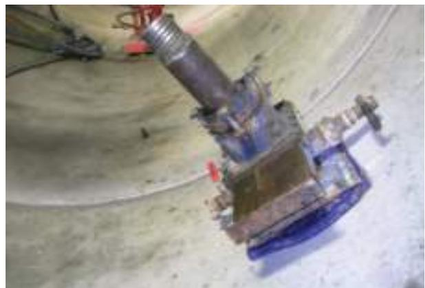
FIGURA 8. Sistema preventivo instalado con válvulas de escape, de inyección, guillotina y sellados.
