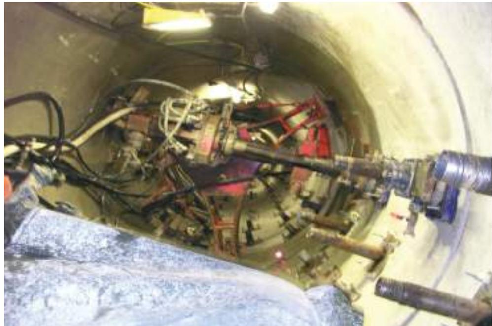
**FIGURA 10.** Sonda perforando taladros en el interior de la galería.
