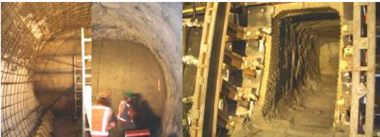
FIGURA 17. Pasaje transversal excavado.
