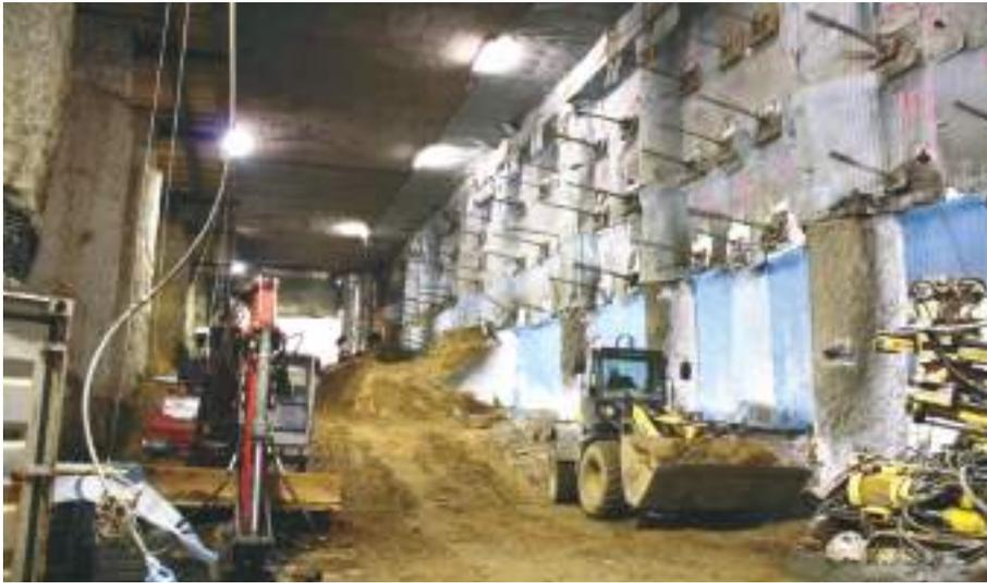
FIGURA 12. Instalación barras de perforación.
