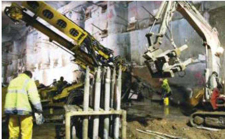
FIGURA 13. Pared anclada y congelada después de la excavación.
