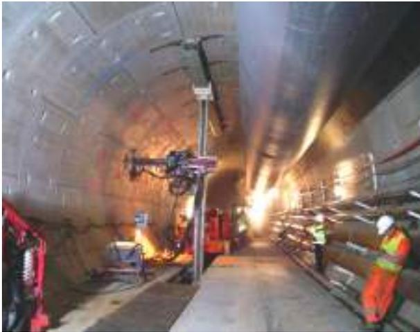
FIGURA 20. Sondas de perforación en el túnel.
