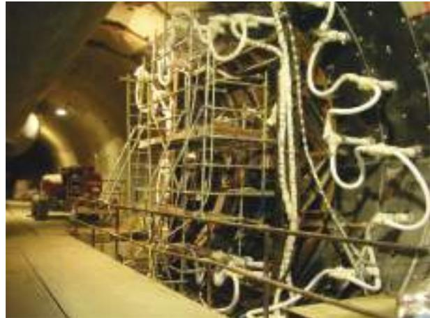
FIGURA 21. Vista del circuito de distribución montado en una galería transversal, junto con la estructura de refuerzo del túnel principal.
