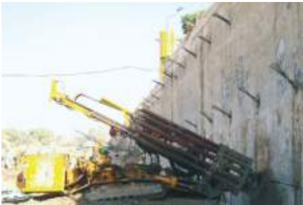
FIGURA 17. Ejecución de anclajes de varios bulbos. Destacan tres factores de dificultad en su ejecución:
