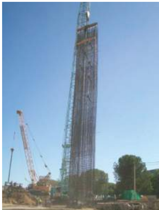
FIGURA 15. Izado de armadura de pantalla de 36 x 5,50 metros con un peso de 29,5 ton. Durante la ejecución de los trabajos se utilizó una grúa de gran tonelaje para el izado de las jaulas. Las armaduras de esquina eran montadas e izadas solidariamente (forma de L).
