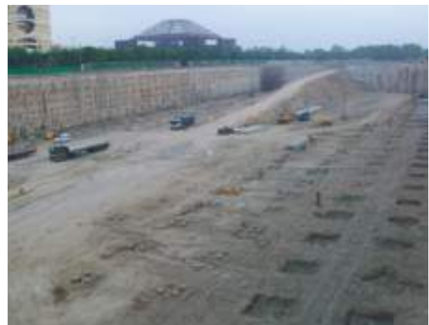
FIGURA 20. Vista general del pilotaje de zona palcos una vez descabezados los pilotes.
