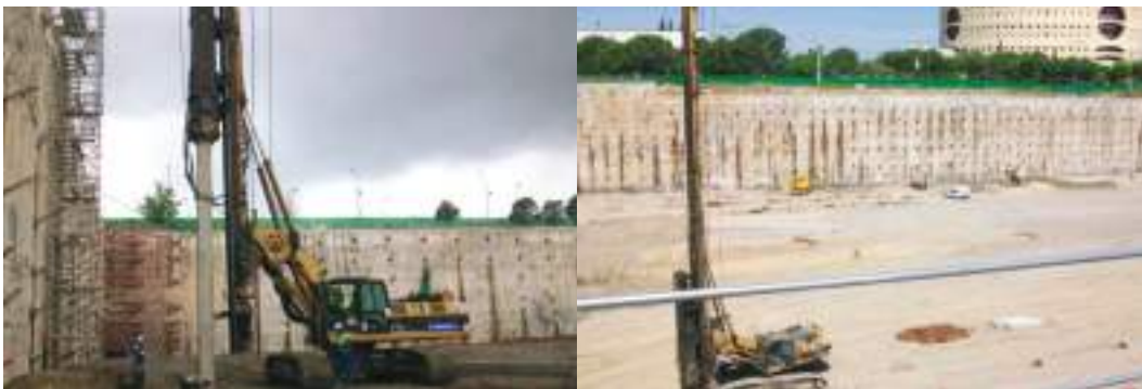
FIGURA 19. Ejecución de los trabajos de hinca.
