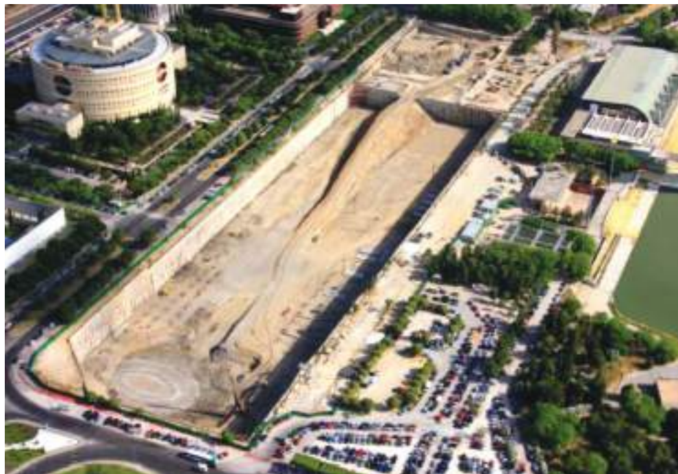
FIGURA 22. Vista de la excavación en vaciado.
