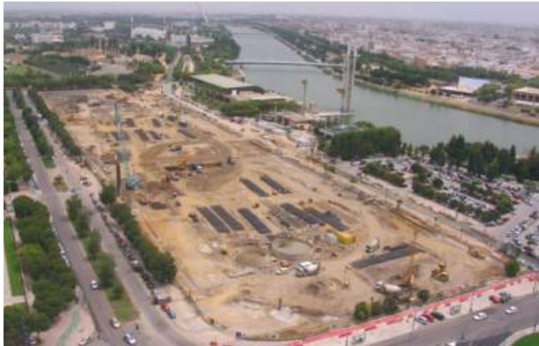
FIGURA 16. Vista general de la obra durante la ejecución de los muro pantalla.
