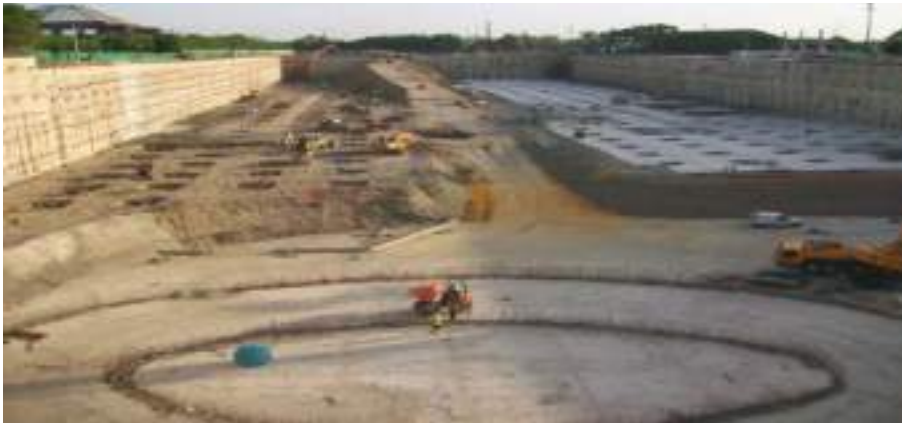
FIGURA 21. Vista general una vez ejecutados y entregados los trabajos de cimentación
