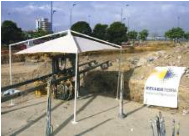
FIGURA 8. Pruebas de anclaje multibulbo en la zona sur.
