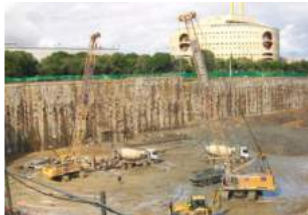
FIGURA 18. Ejecución del doble anillo de pantallas para cimentación de la torre. Factores de dificultad:
