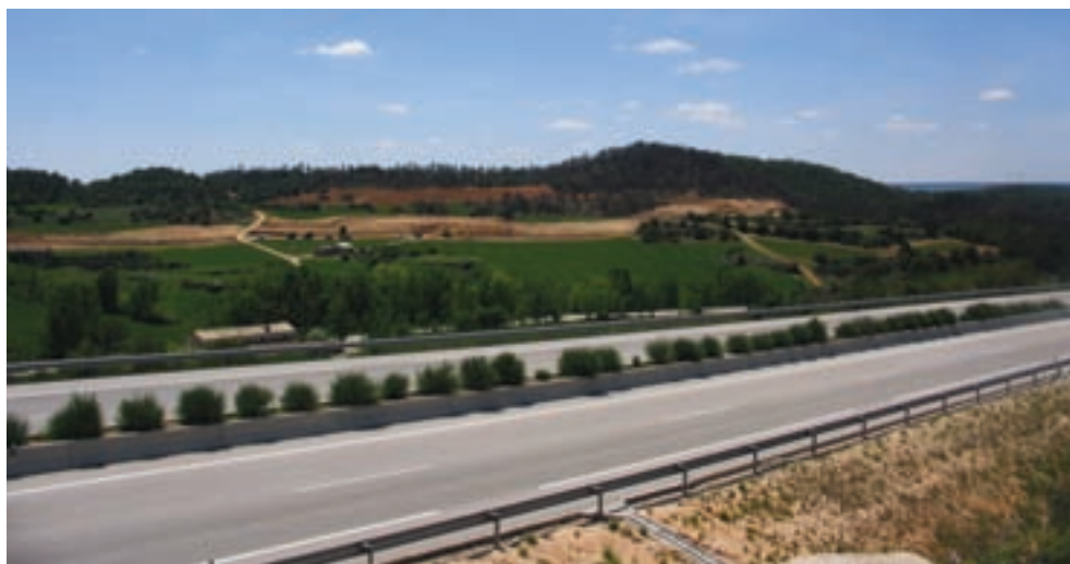
FIGURA 2. Área de estudio, en primer plano la autovía A-40 y en segundo plano las obras de construcción de la LAV Madrid-Levante.
