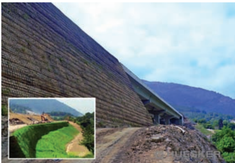
FIGURA 4. Muro verde reforzado con geomalla utilizado como estribo de un puente. / FIGURE 4. Geogrid reinforced green wall used as bridge abutment.
