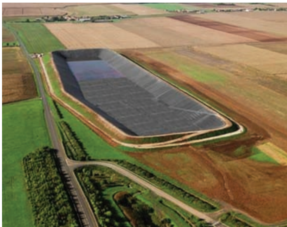
FIGURA 2. Balsa de riego impermeabilizada con una geomembrana. / FIGURE 2. Irrigation reservoir lined with geomembrane.
