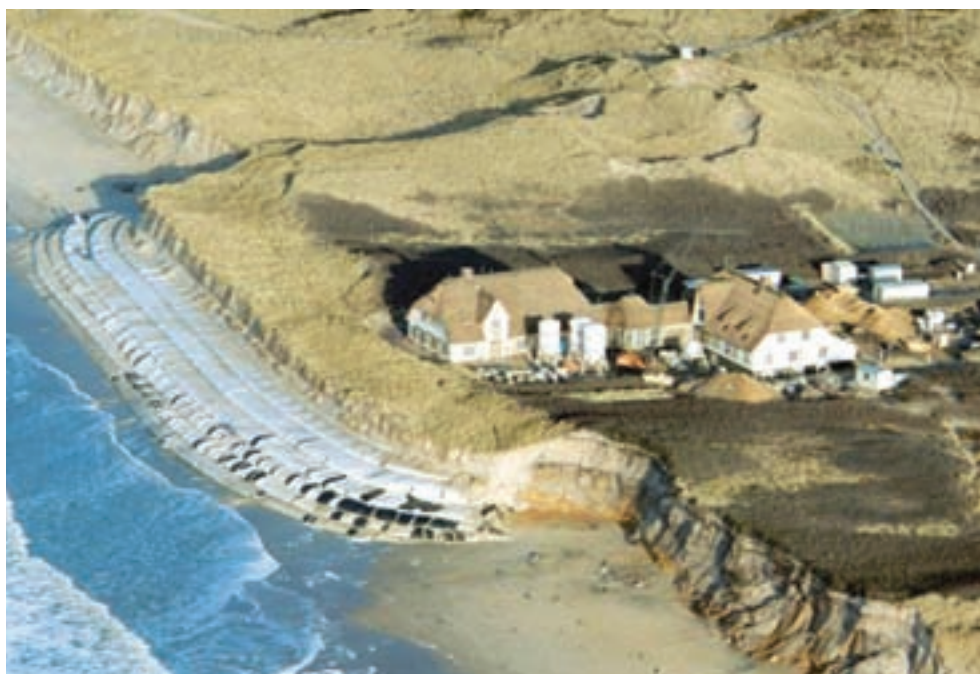
FIGURA 10. Geocontenedores utilizados para protección de la costa. /
