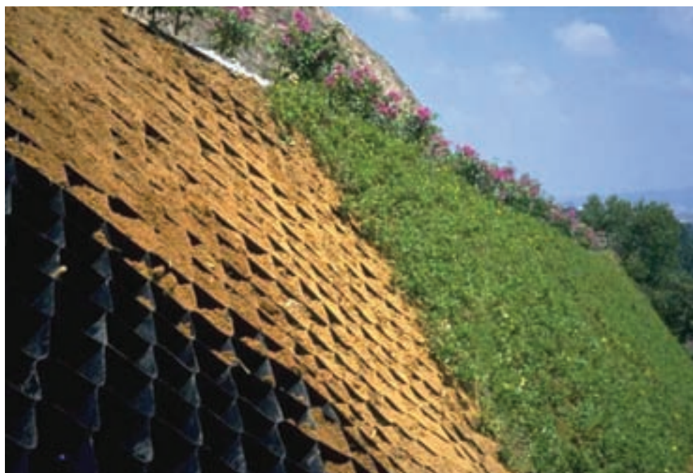
FIGURA 11. Geocelda utilizada para favorecer el crecimiento de vegetación para control de la erosión. / FIGURE 11. Geocell used to promote vegetation growth for erosion control.
