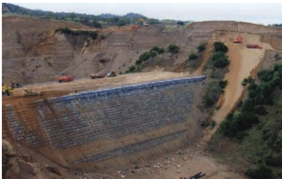
FIGURA 5. Vertedero tras un terraplén reforzado con un geosintético. / FIGURE 5. Landfill behind geosynthetic-reinforced embankment.
