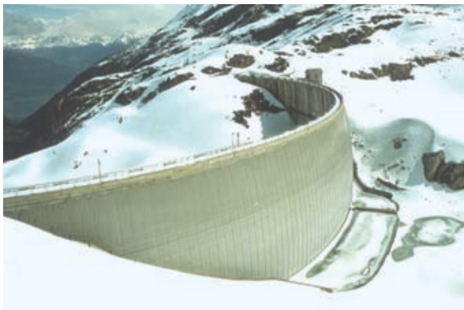
FIGURA 1. Presa de hormigón rehabilitada con geosintéticos. / FIGURE 1. Concrete dam rehabilitated using geosynthetics.
