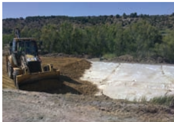
FIGURA 6. Fase I, Ejecución de la plataforma.
