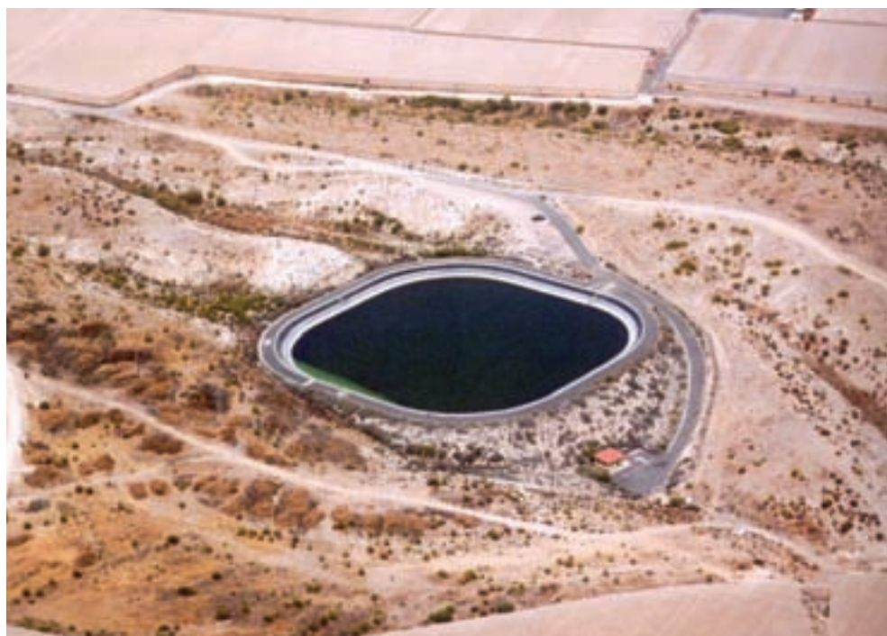
FIGURA 2. Balsa de San Isidro cuya geomembrana impermeable es de PEAD.
