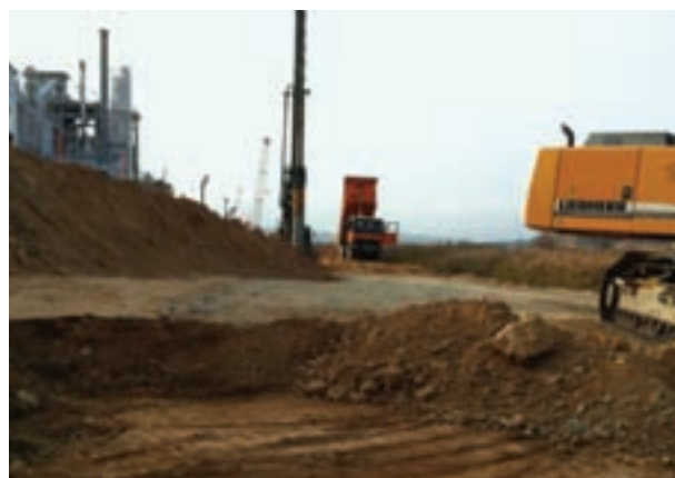
FIGURA 7. Fase II, Ejecución de la pantalla.
