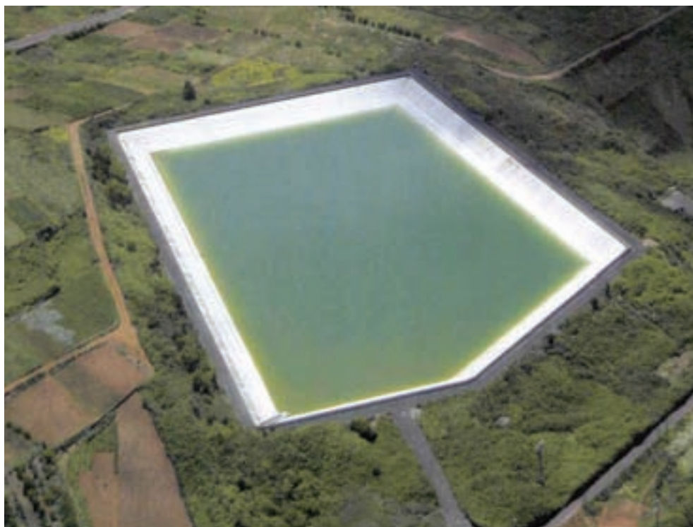
FIGURA 1. Balsa de Los Llanos de Mesa impermeabilizada con una geomembrana de PVC-P.
