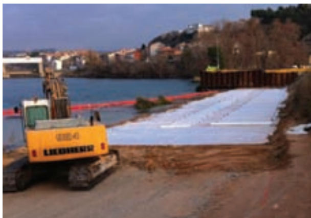
FIGURA 5. Detalle desenrollado del geosintético de refuerzo.
