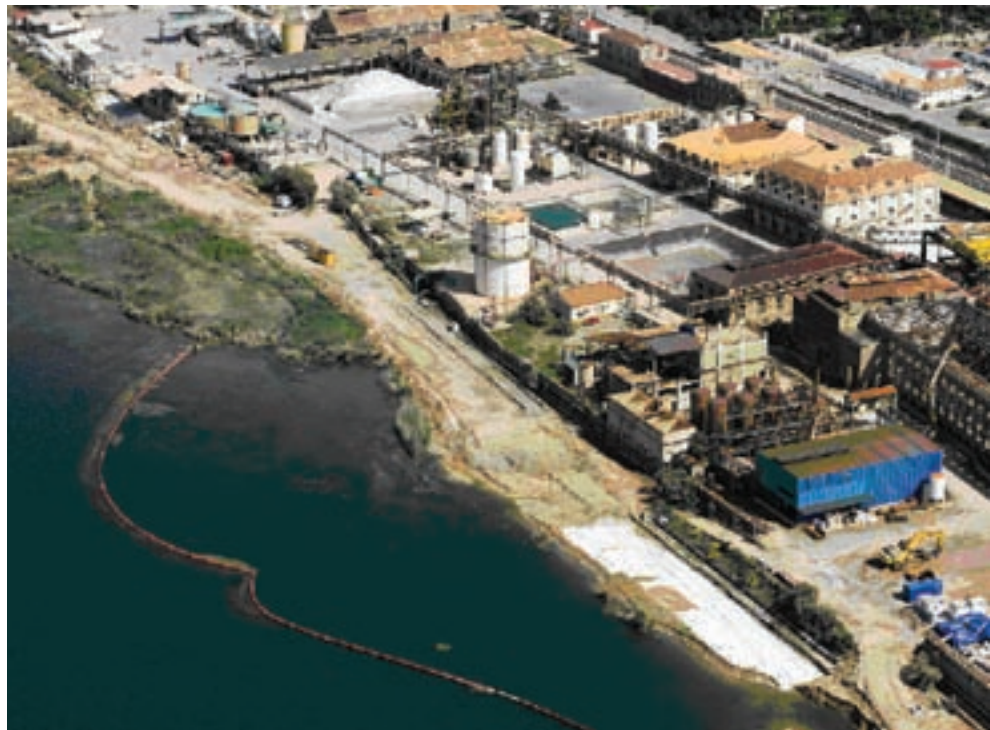
FIGURA 8. Vista aérea de la obra durante la colocación del geotextil de refuerzo.
