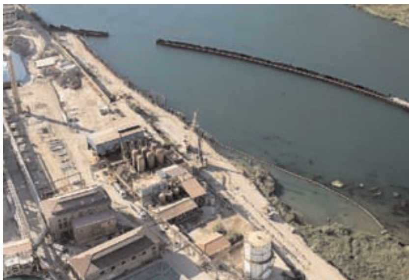
FIGURA 2. Vista aérea de la obra durante la ejecución del muro exterior e interior.
