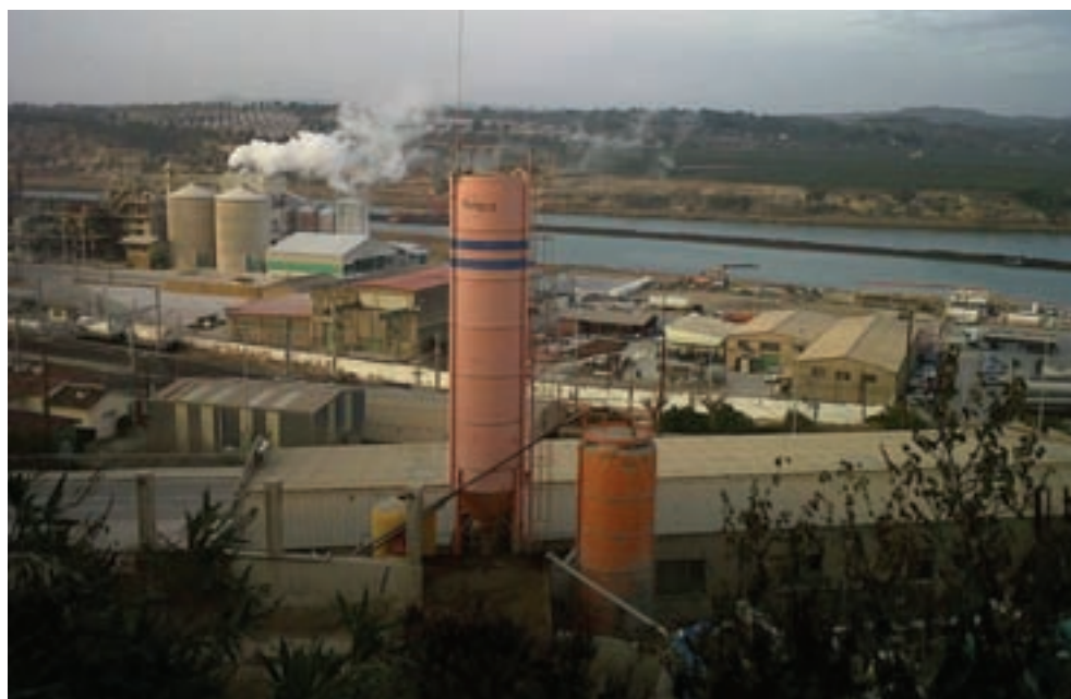
FIGURA 1. Vista general de la obra.
