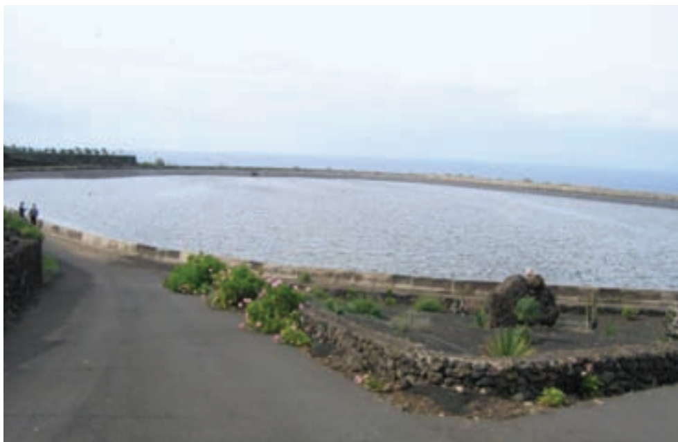
FIGURA 3. Aspecto de la balsa de El Golfo impermeabilizada con una barrera geosintética polimérica a base de EPDM.
