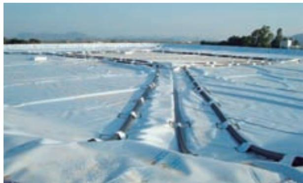
FIGURA 7. Cubierta flotante con LLDPE de 1,5 mm de espesor y de color Blanco/Negro.
