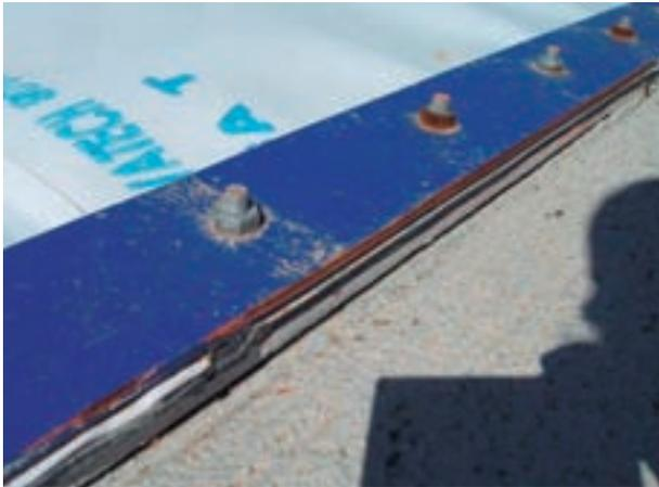
FIGURA 2. Fijación de la cubierta flotante al embalse. Dos placas de acero de 80x5 mm y tornillos de 7x13 mm cada 200 mm.
