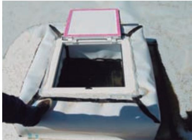
FIGURA 5. Arqueta instalada en la cubierta flotante.
