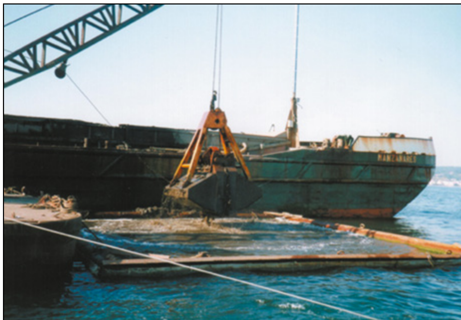
Foto 1. Dragas de cuchara operando en el interior de un recinto dotado de pantalla antiturbidez.
