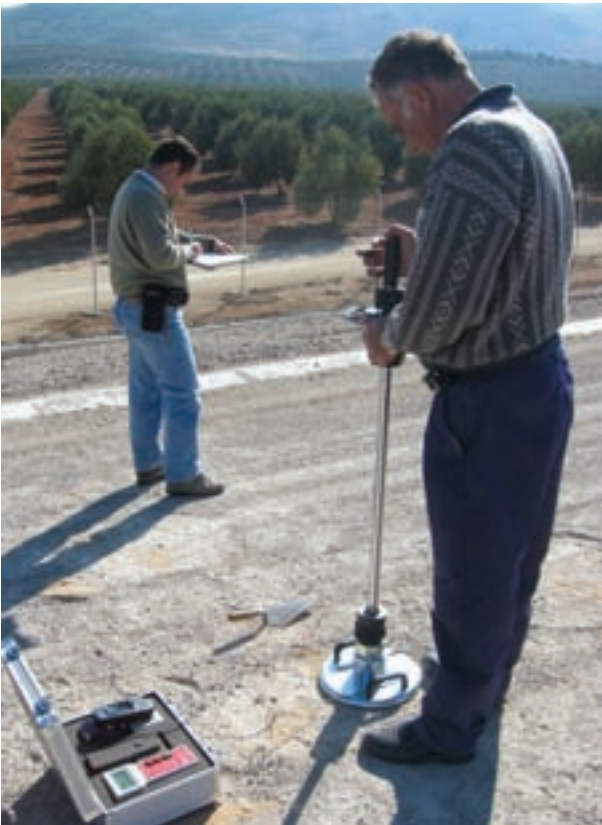
FIGURA 5. Ejecución de ensayo de la placa ligera alemana.
