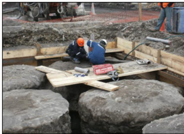
**Figura 6.** Extracción de testigo en Campo de Prueba (Pilotes Terratest S.A., 2011).
