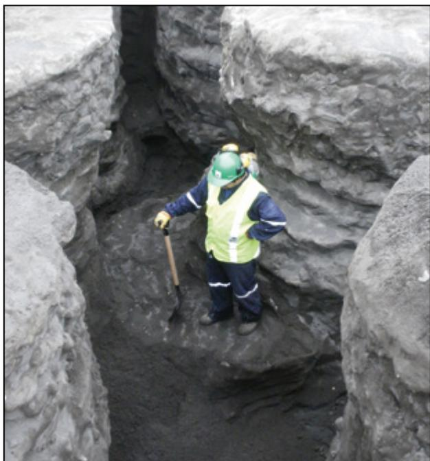
**Figura 5.** Inspección visual columnas de prueba (Pilotes Terratest S.A., 2011).
