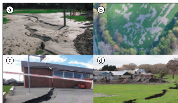
Figura 1. (a) y (b) Erupción masiva del suelo hacia la superficie (Sand Boils), (c) colapso de la fundación de una iglesia por rotura del terreno (grieta de 50-90 cm de ancho y altura de 33cm como máximo), (d) desprendimiento lateral (Lateral Spreading) (Christchurch, Nueva Zelanda) (Rathje et al., 2010).
