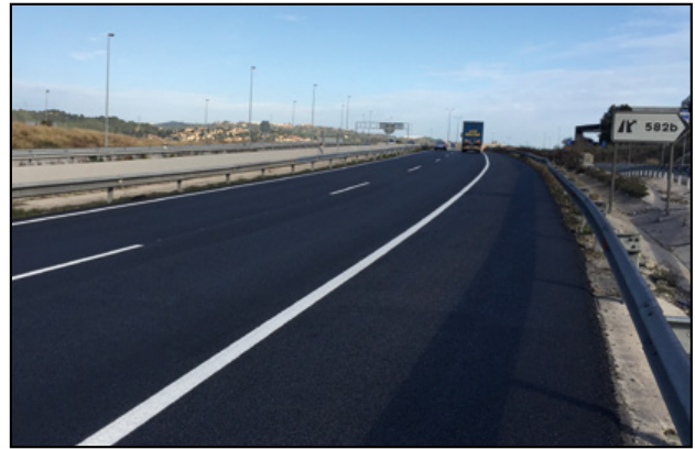
Figura 18. Vista de la curva rehabilitada.
