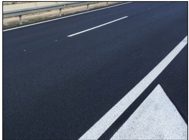
Figura 20. Aspecto de la mezcla fabricada con árido siderúrgico.
