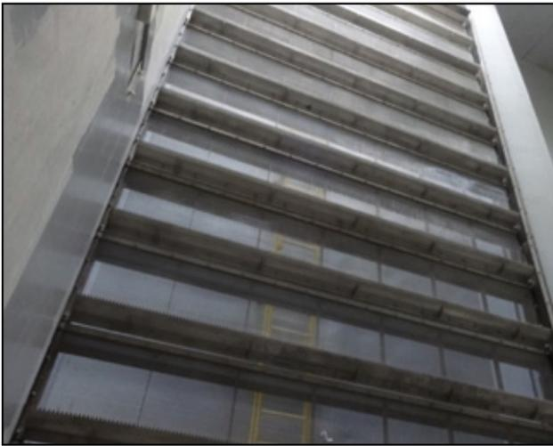
**Figura 29.** Sistema de filtrado con reja auto-limpiante.
