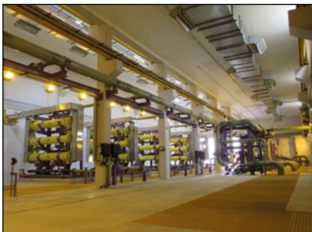
**Figura 1.** Planta de electrocloración asociada a la SWIPS II.
