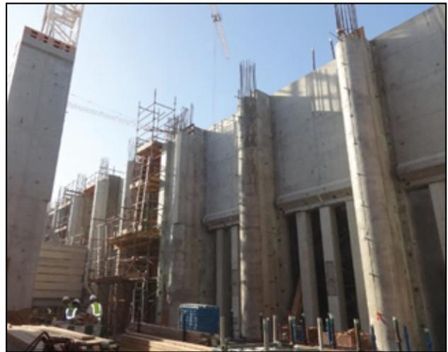
**Figura 27.** Construcción de embocadura de las cámaras de bombeo.
