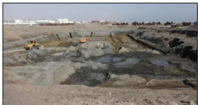
**Figura 23.** Retirada de material en la zona de cimentación de la SWIPS II.
