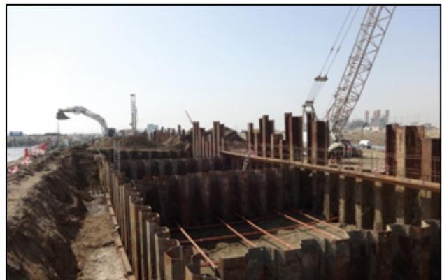
**Figura 22.** Definición del recinto mediante sistema de tablestacas.
