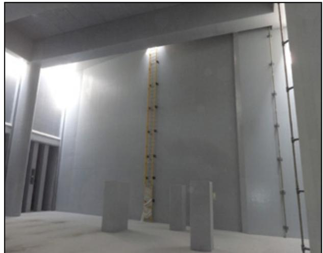
**Figura 28.** Revestimiento con pintura epoxi en las superficies de una bahía de distribución.
