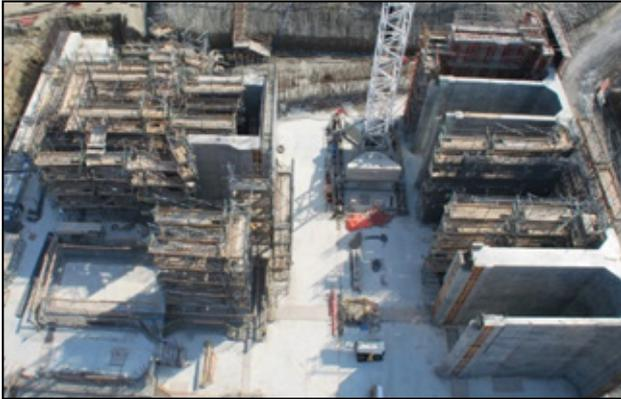
**Figura 24.** Construcción de la solera de hormigón.
