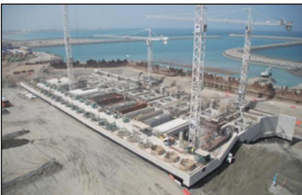
**Figura 26.** Construcción de la cubierta (losas superiores) de la SWIPS II.
