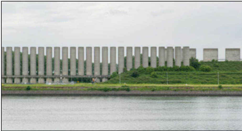
Figura 15. Pantallas antiviento Canal de Calandkanaal. Puerto de Rotterdam.
