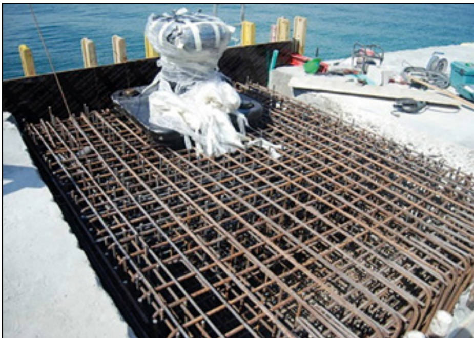
Figura 6. Macizo de apoyo fuertemente armado.
