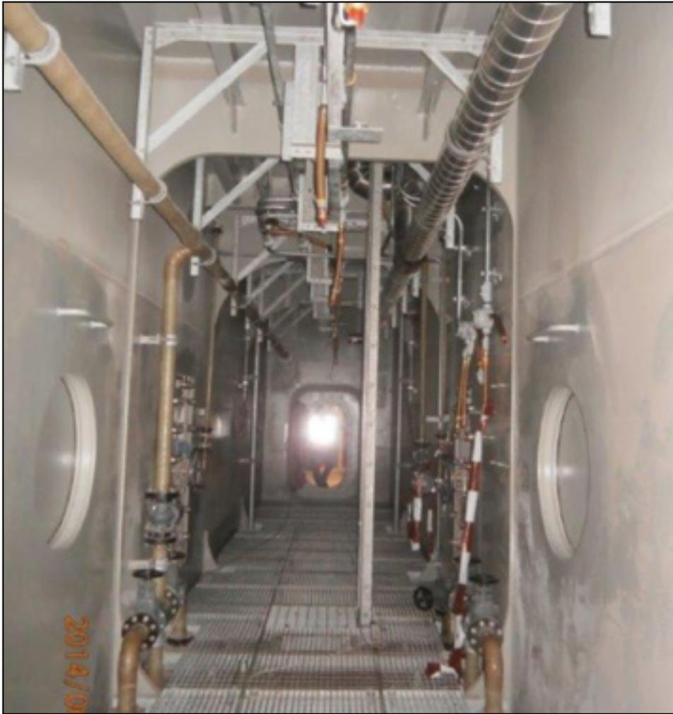
**Figura 21.** Vista interior del pasillo que da acceso a las cámaras de flotación de una compuerta.
