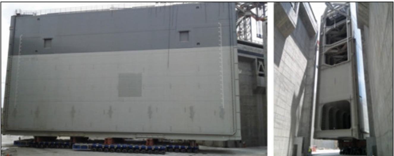
**Figura 25.** Diferentes fases de la instalación de la compuerta mediante carros de transporte especiales.
