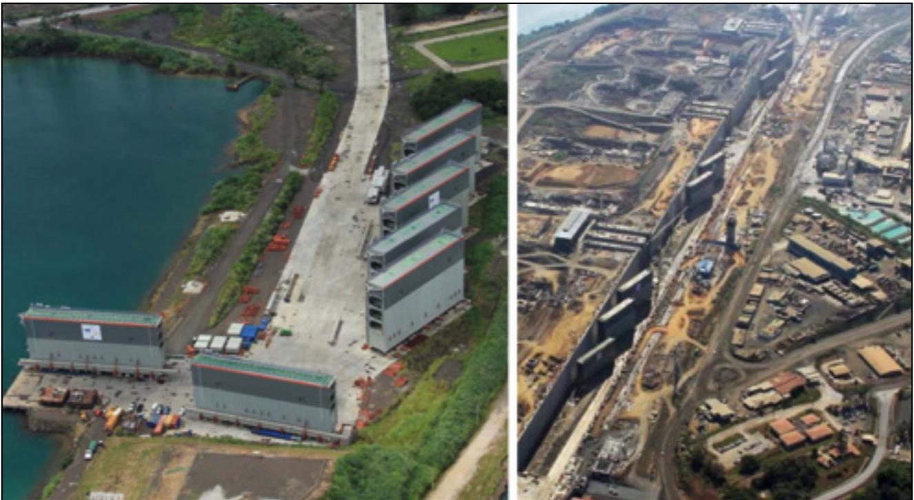
**Figura 24.** Almacenamiento y transporte de las compuertas hacia su ubicación definitiva.
