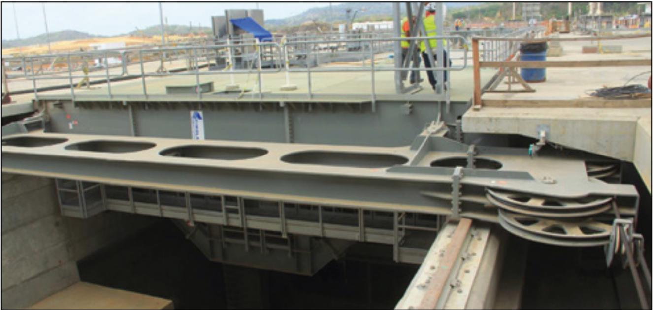
**Figura 31.** Vista de la viga de soporte de las poleas.
