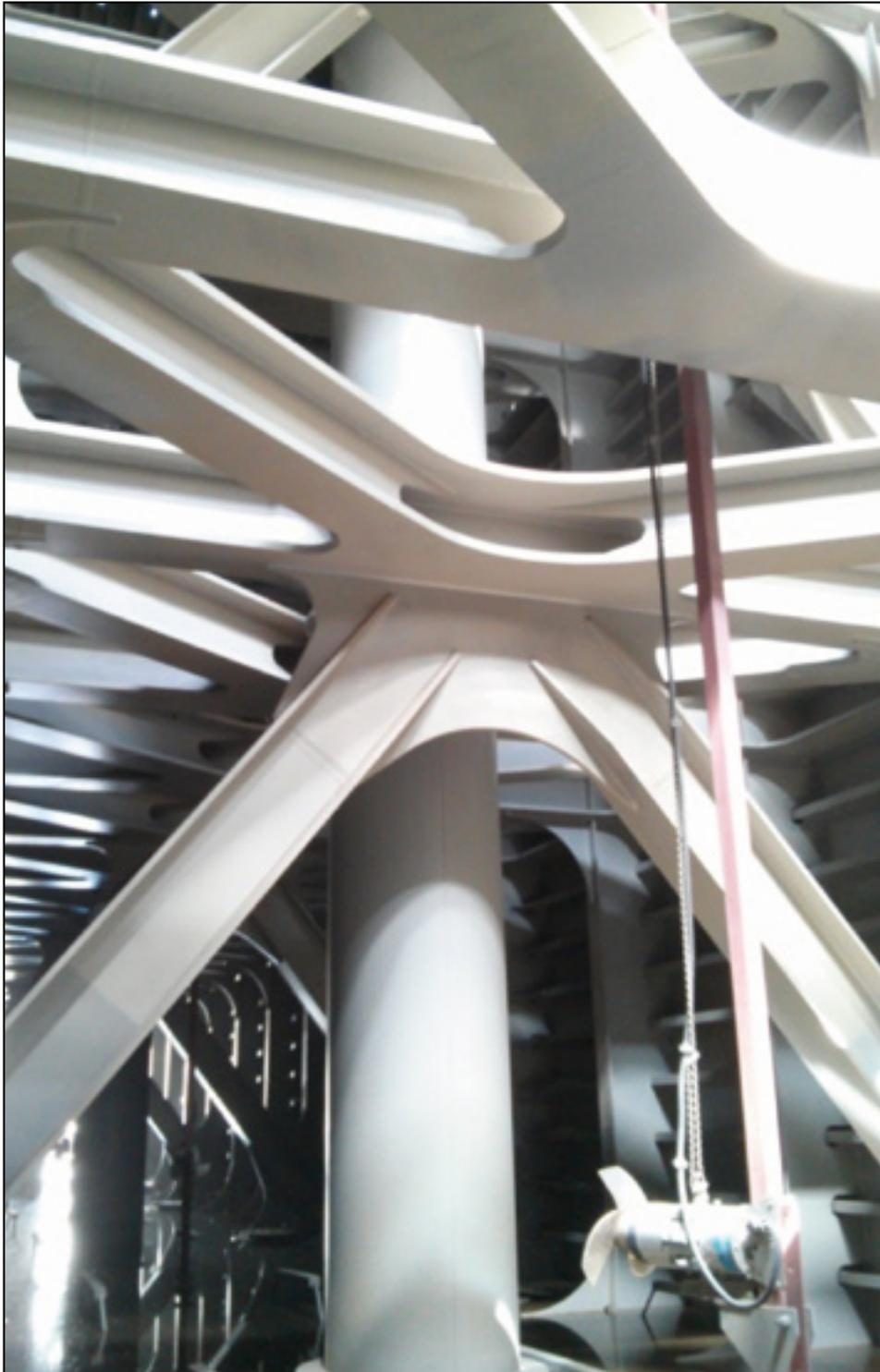
**Figura 34.** Vista del interior de la compuerta en la zona sobre la cámara de flotación.
