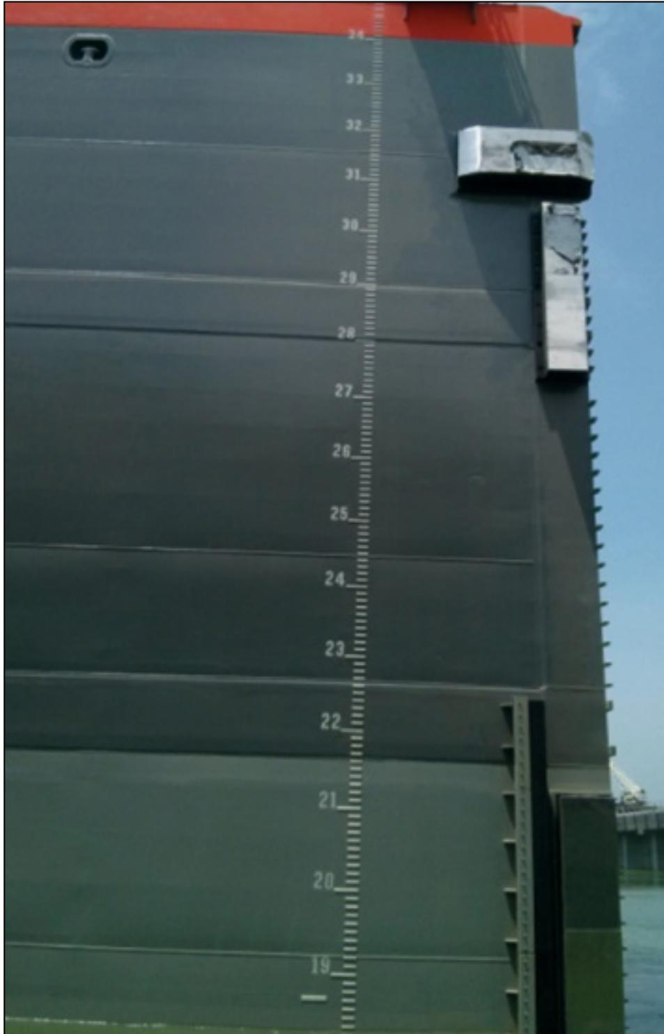
**Figura 33.** Vista general de los bloques de soporte y guiado de la compuerta.
