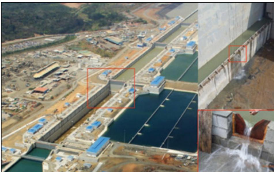
**Figura 44.** Medición de fugas en compuertas.
