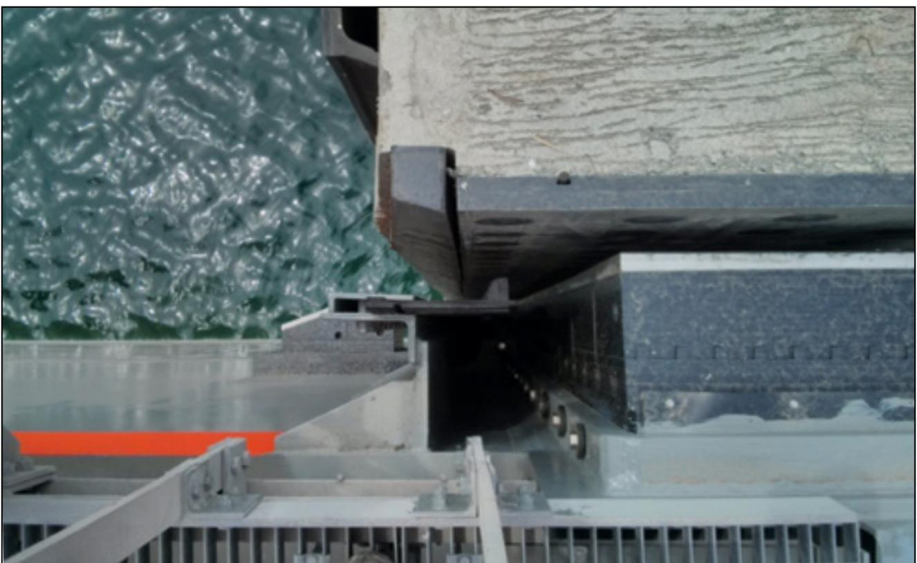
**Figura 32.** Vista general del perfil de sellado de la compuerta.
