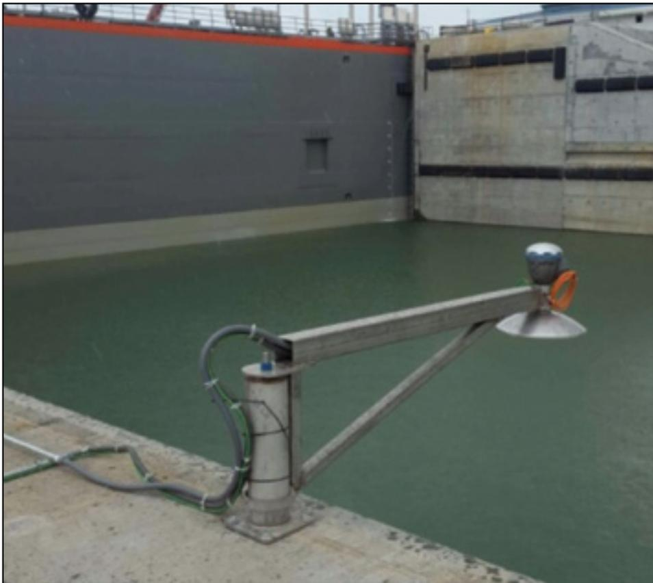
Figura 46. Transmisores de nivel para medir nivel en cámaras.
