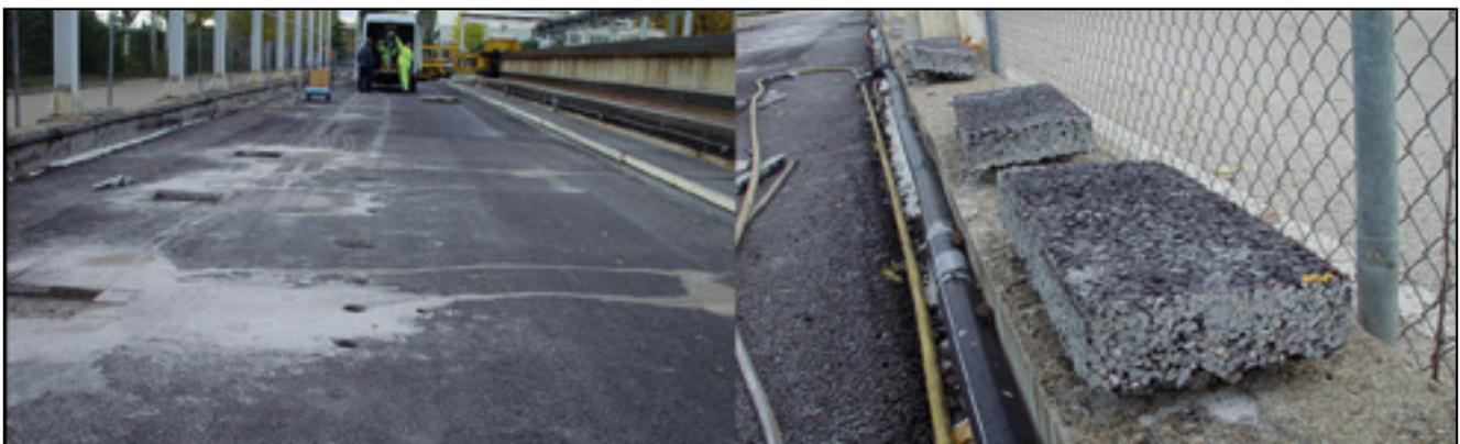
Figura 5. Extracción de catas de mezcla bituminosa.
