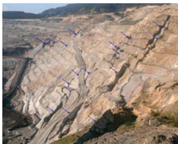
**Figura 22.** Vista general del talud NE con los escarpes producidos por los vuelcos.
