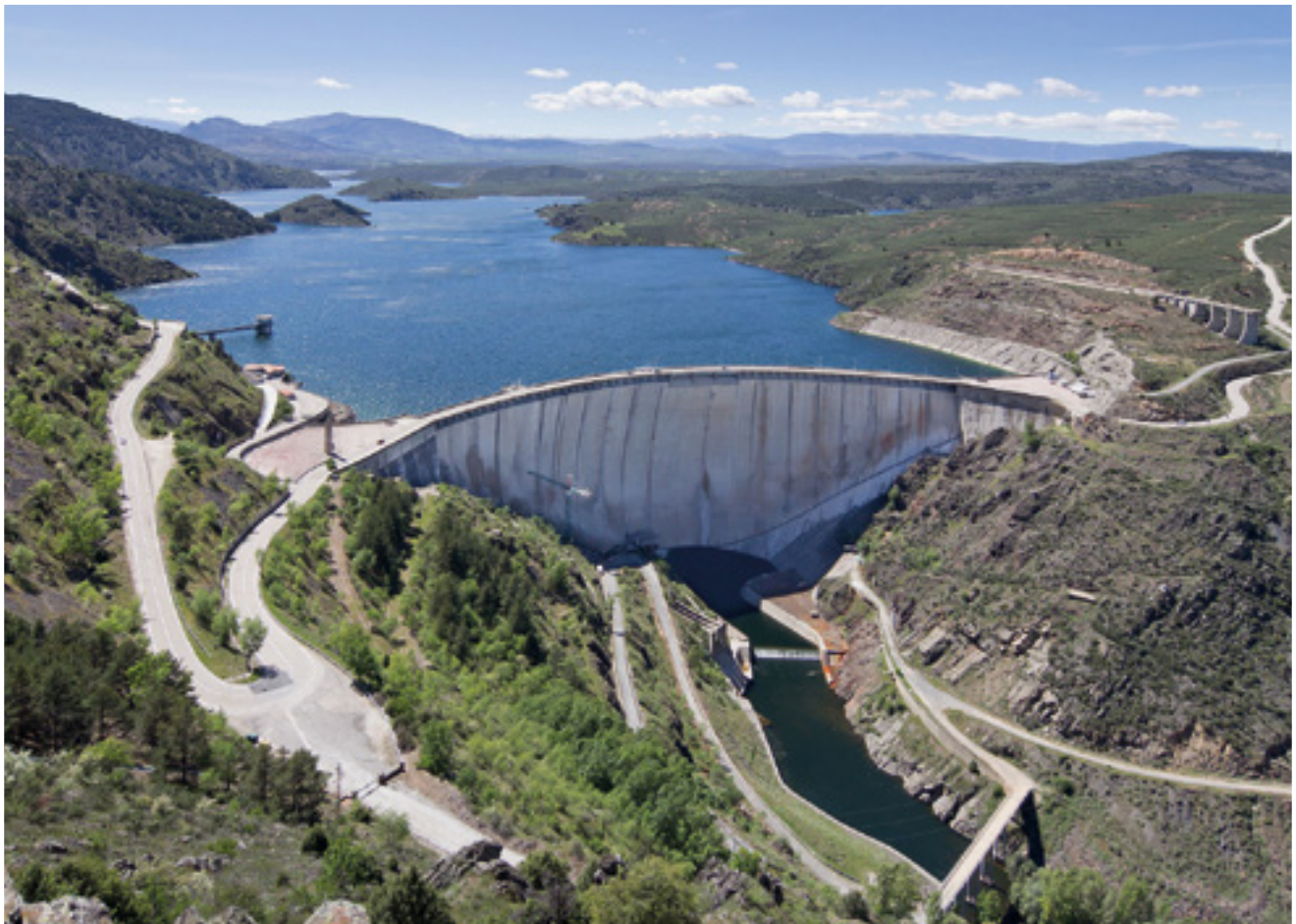
Figura 2. Presa del Atazar (se observa el tratamiento del talud en la zona de aguas arriba del estribo izquierdo; nótese que la “piel” de hormigón proyectado cubre el talud solamente en su parte inundable por la subida del embalse).
