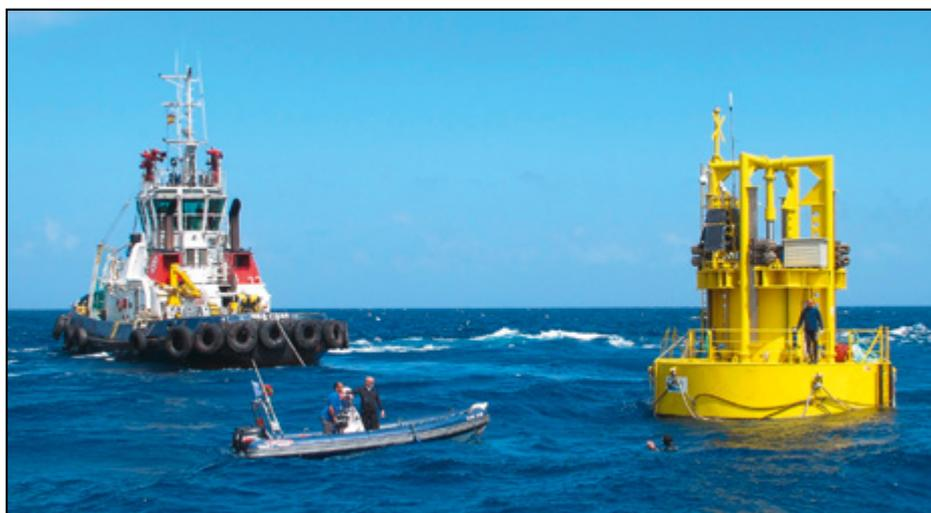
Figura 9. Maniobra de remolcado del captador y de anclaje al fondo marino.
