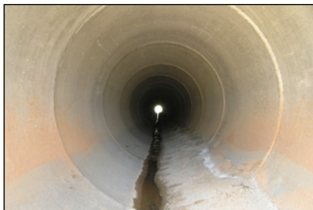
Figura 4. Drenaje circular de 1,8 m de diámetro adaptado al paso de la fauna mediante una plataforma inclinada en la base. Junto con los pasos superiores multifuncionales, han sido las estructuras de cruce menos usadas por las especies estudiadas.
