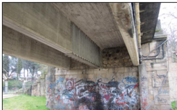
**Figura 6.** Fondo del tablero y estribo sur.
