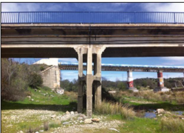
**Figura 8.** Pila norte; se aprecia la junta del tablero.
