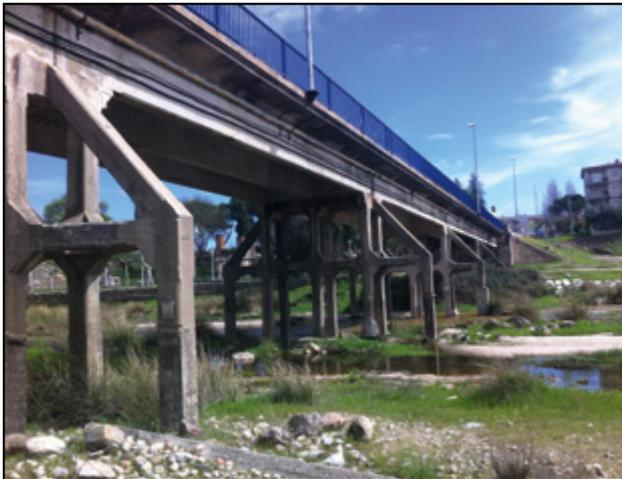
**Figura 10.** Pilas. Se aprecian dos hormigones distintos en pilotes y pilares, y algunos refuerzos desafortunados.
