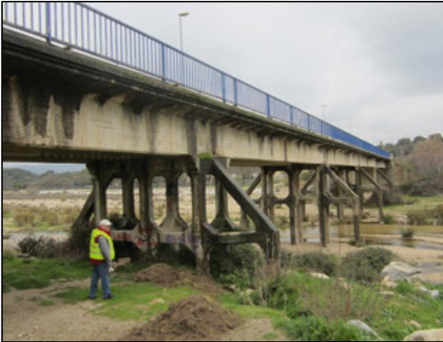
**Figura 17.** La pila sur, en primer plano, es la única que no ha sido descalzada.
