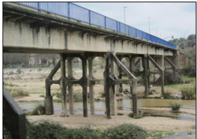
**Figura 16.** Las pilas, vistas desde el estribo sur. En el pilar más a la izquierda, la dudosa reparación por encamisado.
