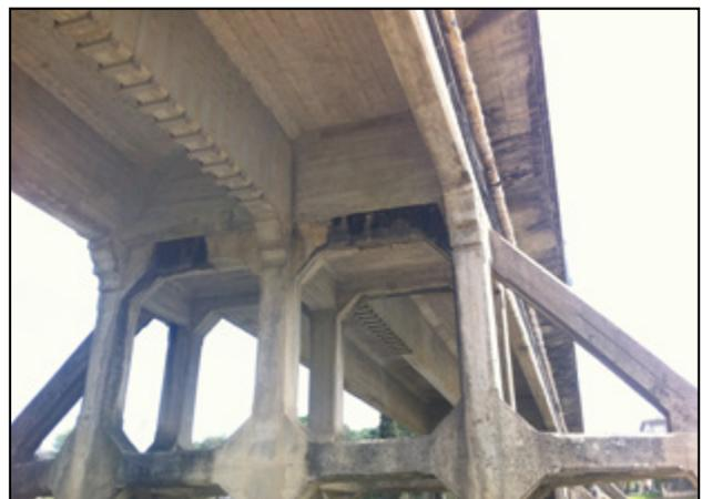
**Figura 9.** Apoyo del tablero sobre las pilas.
