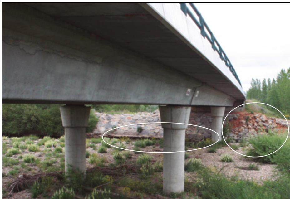
**Figura 13.** Tras la realización de un dragado para el mantenimiento de las condiciones de desagüe de un puente, la deposición de nuevo material en los ojos centrales ha restado eficacia a la actuación. Además ha provocado la concentración del flujo en una de las márgenes (al fondo de la imagen), causando el socavamiento del estribo en toda su longitud (río Curueño, Barrio de Nuestra Señora, León).
