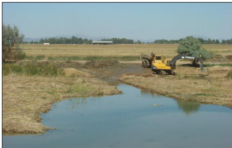
**Figura 15.** Eliminación de caña común mediante métodos mecánicos y dragado parcial del cauce (río Guadiana, Badajoz).
