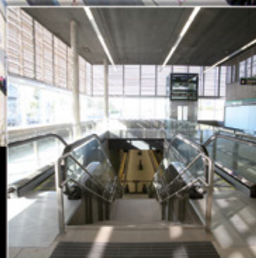
Metro de Málaga. Supervisión de los proyectos y de las obras de las líneas 1 y 2
