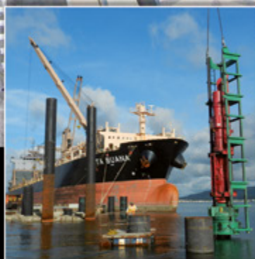
Puerto Cortés, Honduras. Proyecto y supervisión de la ampliación de la terminal de graneles sólidos
