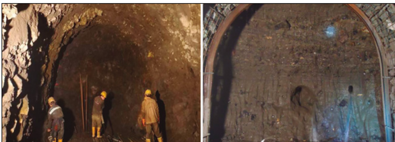
Imágenes 9 y 10. Ventana 3. Se interceptaron sedimentos del paleocauce en la abs. 0+219 m, con un elevado flujo de agua. Se paralizó la excavación en la abscisa 0+226. (Cortesía de Astec).
