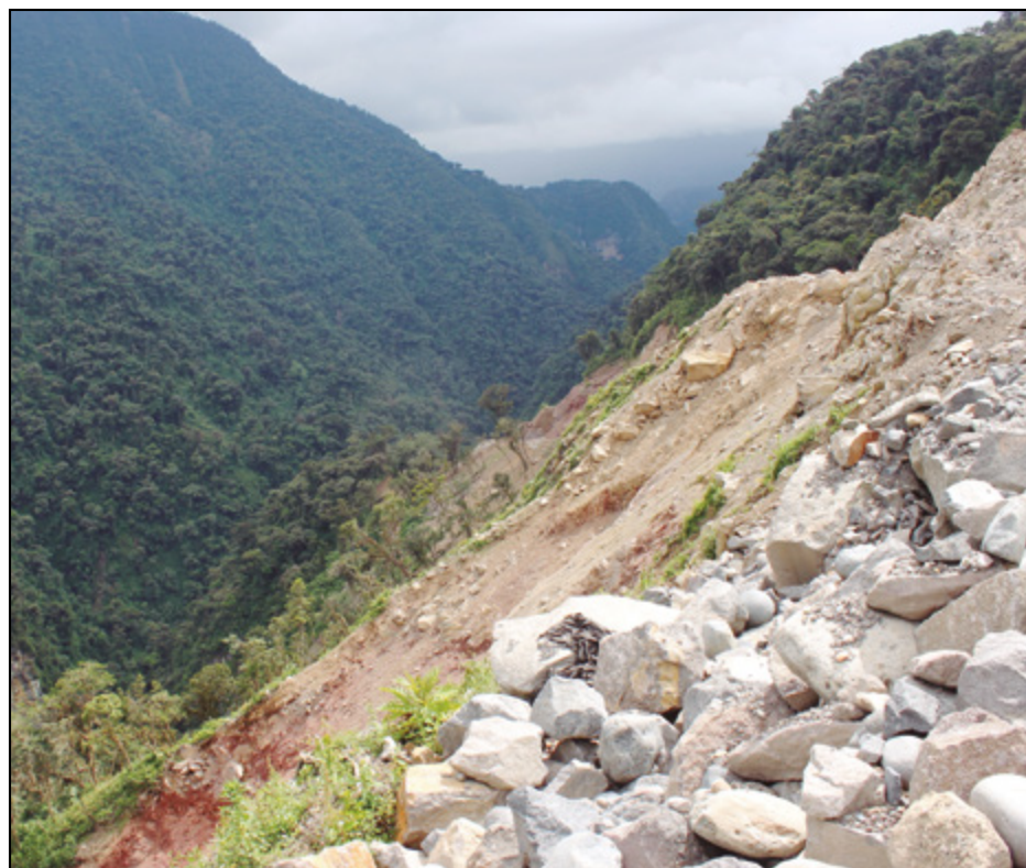
Imagen 1. Vial de acceso a la toma Quijos (Pendiente máx. 21%).
