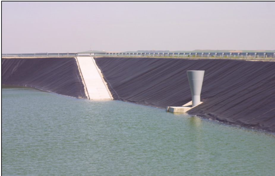
Figura 3. Balsa de la Nava de Arévalo, impermeabilizada con PEAD.
