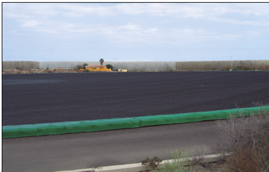
Figura 7. Balsa cubierta de El Saltadero, impermeabilizada con PVC-P.
