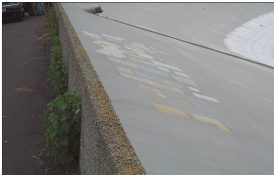
Figura 8. Zona de extracción de muestras en la zona norte de coronación de la geomembrana de PVC-P de la balsa de La Florida (Icod de los Vinos-Tenerife).
