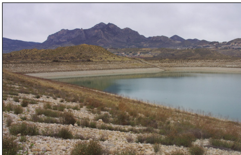
Figura 2. Balsa de Plá Mateos, impermeabilizada con polietileno de baja densidad (PEBD).
