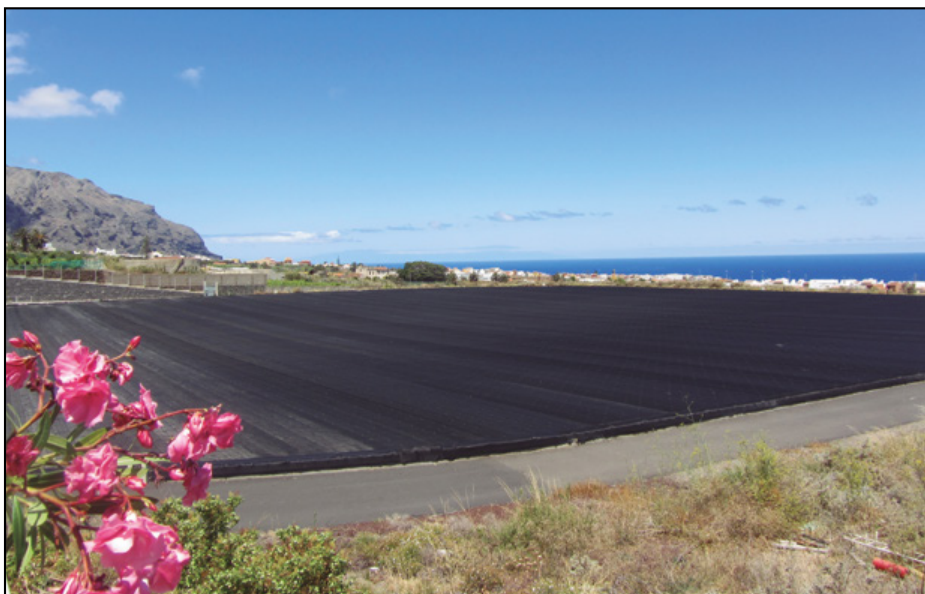
Figura 6. Balsa cubierta de Ravelo, impermeabilizada con EPDM.
