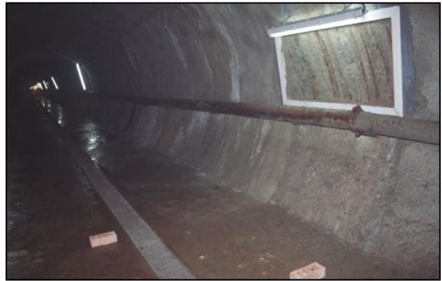
**Figura 23.** Aspecto del Flysch calcáreo perteneciente a la Unidad de Algeciras en la ventana geológica (V-10) frente a la que se perforaron los seis sondeos de la Zona 3. Se aprecia un buzamiento del orden de 85° hacia el interior de la galería (NO).
