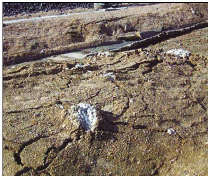
**Figura 2.** Detalle de agrietamientos y recristalizaciones en las cercanías de la plataforma ferroviaria.
