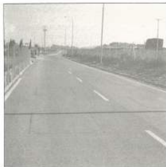
FIGURA 1. Vista general de una estación de aforo automático con captadores de bucles de inducción.
