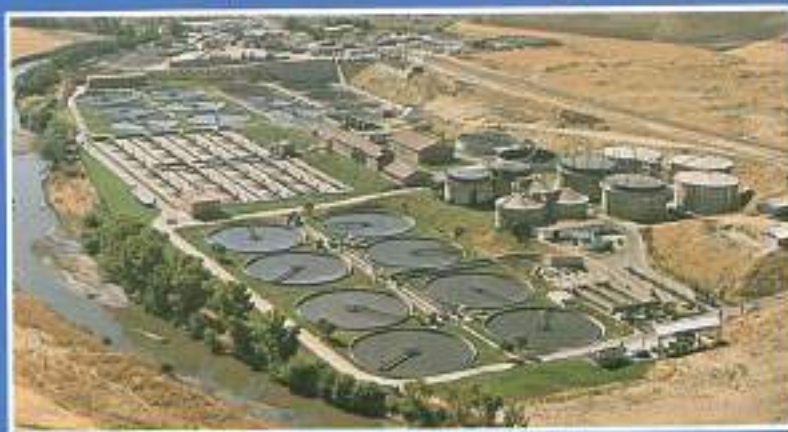
Depuradora de Butarque - Madrid
