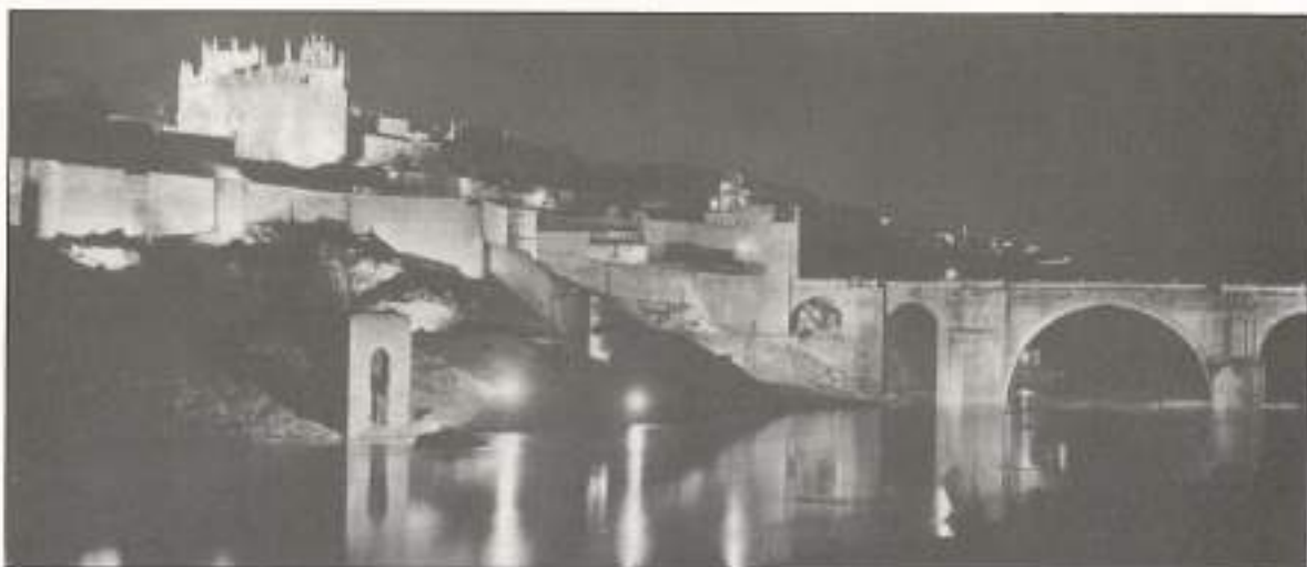
FIGURA 5. Puente de San Martín (Toledo). Es parte del paisaje urbano.
