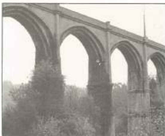
FIGURA 7. Viaducto Puente Mera (Línea Ferrol-Gijón).
