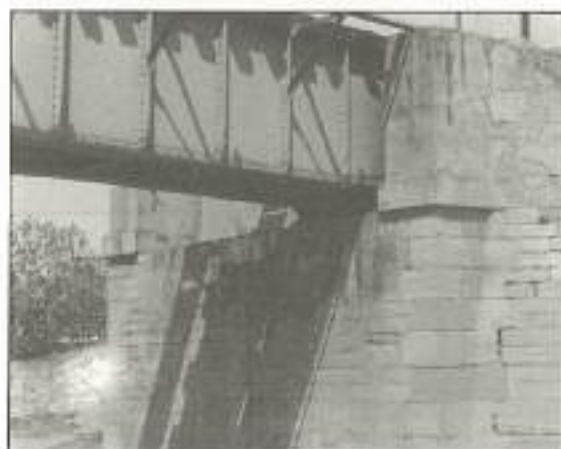
FIGURA 8. Estribo (Línea Castejón-Bilbao).
