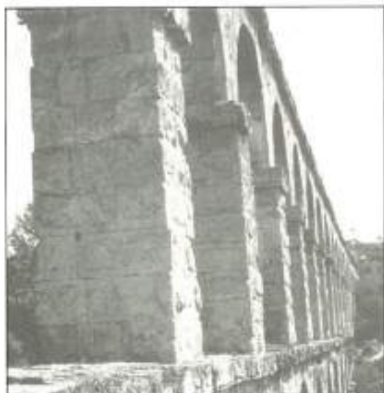
FIGURA 2. Acueducto del Diablo (Tarragona).
