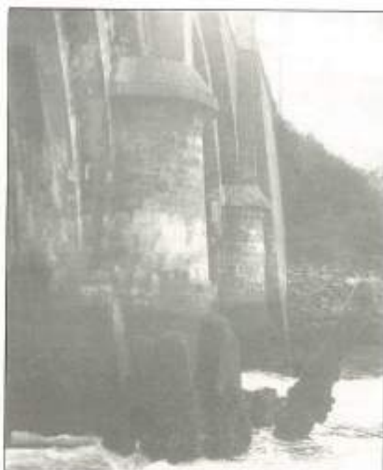
FIGURA 9. Puente (Ría de Ortigueira).
