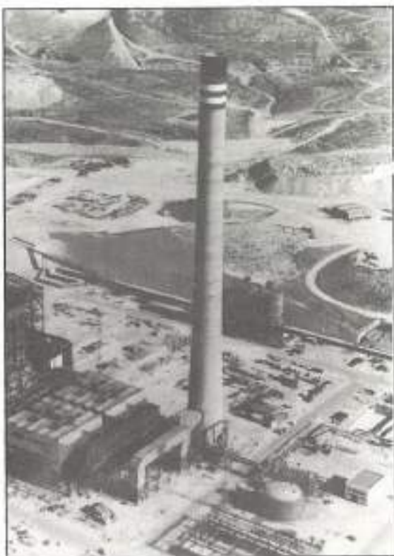
FIGURA 1. Vista de la chimenea de 200 m de altura.
