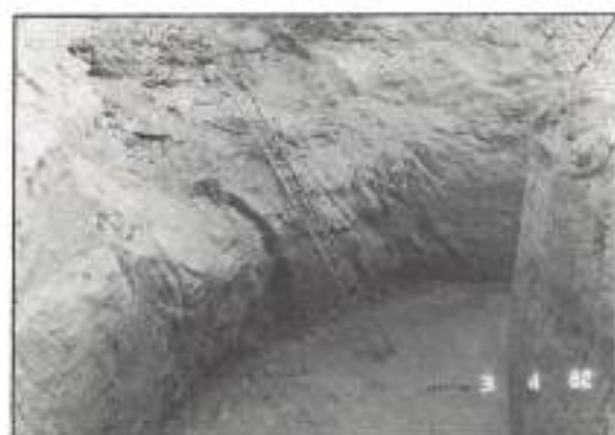
FIGURA 3. Excavación anular para la cimentación de la chimenea en arenisca calcárea.
