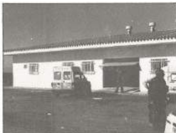
FIGURA 3. Laboratorio de Obra, ala Sur-Este.
