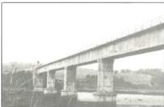
FOTO 1. Inspección de cimentaciones.
