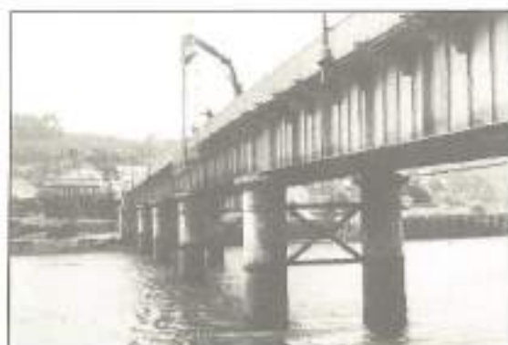
FOTO 4. Inspección de superestructura.
