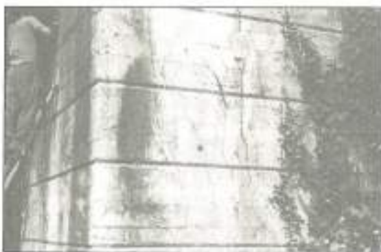
FOTO 2. Inspección de estribos y sistemas de apoyo.
