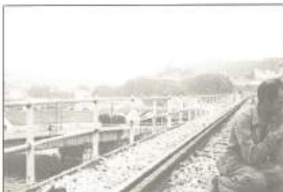
FOTO 5. Inspección de equipamientos, balastro y vía.
