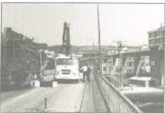
FOTO 3. Inspección de superestructura
