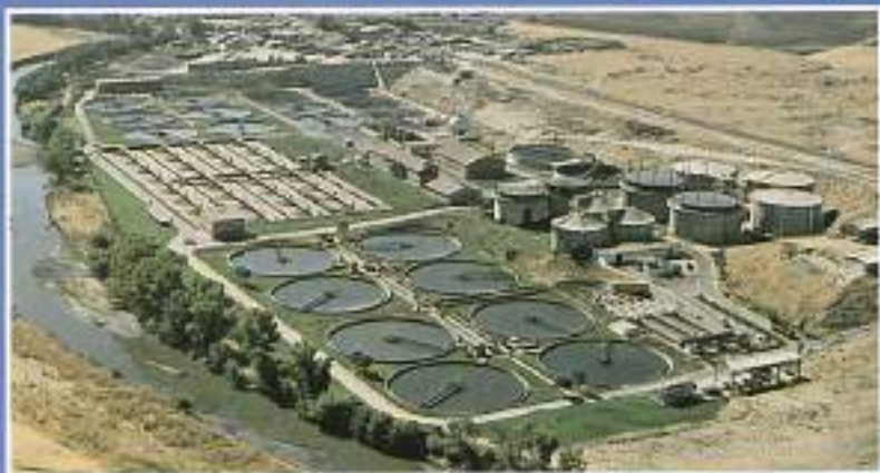
Depuradora de Butarque - Madrid
