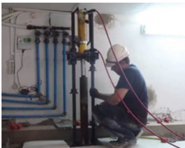
Figura 12. Hinca del micropilote en espacio con gálibo reducido. 2PE Pilotes SL, 2014.
