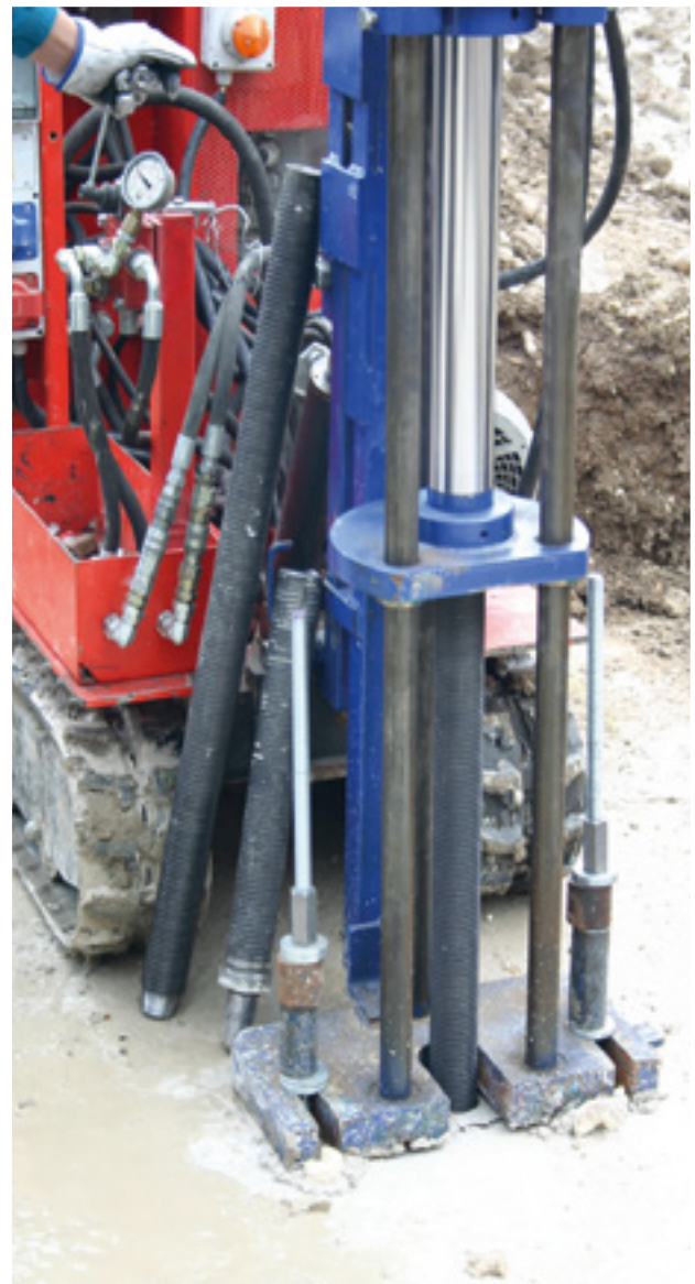
Figura 15. Hinca del micropilote. Cortesía de Geonovatek, 2017.
