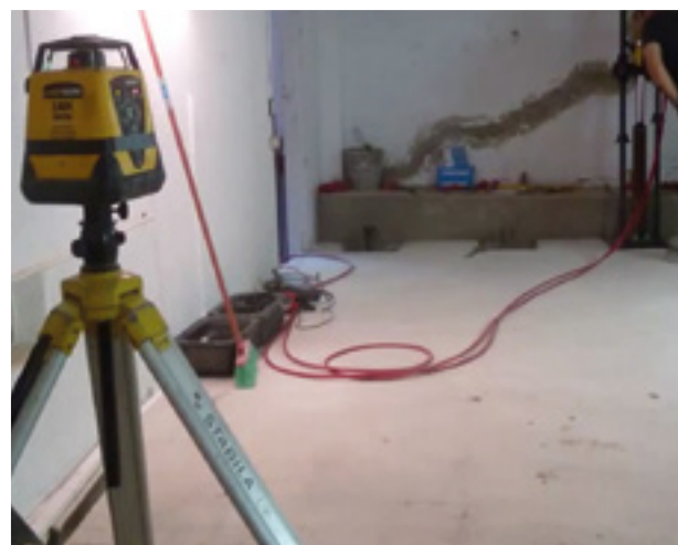
Figura 13. Control topográfico de movimientos. 2PE Pilotes SL, 2014. Interwest y Magnum Piering Inc, 2017.
