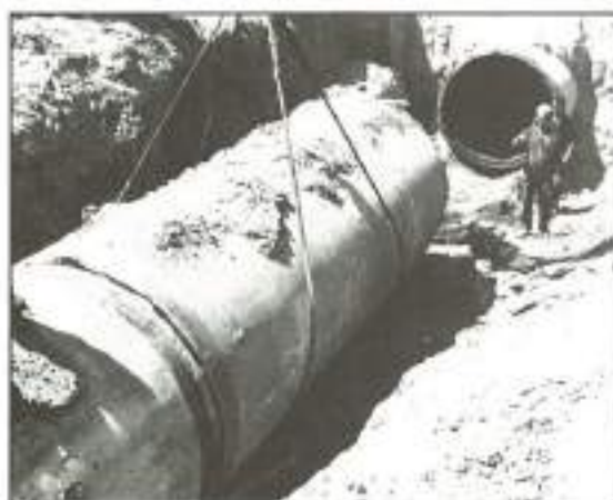
FOTO 17. Desmontaje del tubo.
