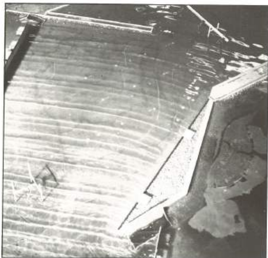
FIGURA 6. Prolongación del Dique Exterior de Las Palmas.
