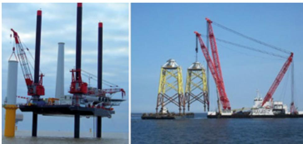
**Figura 2.** Barco Jack-up instalando monopiles y gran grúa flotante instalando jackets.
