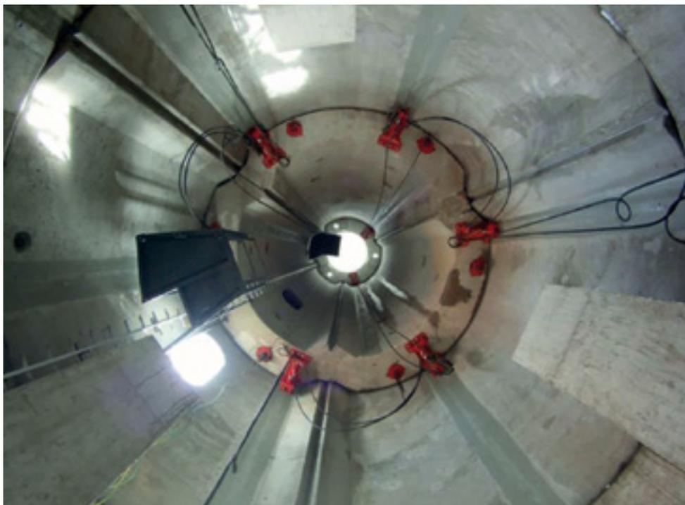
**Figura 4.** Tecnología ELISA. Vista interior de torre telescópica de prueba a escala real construida en Daganzo de Arriba, Madrid.
