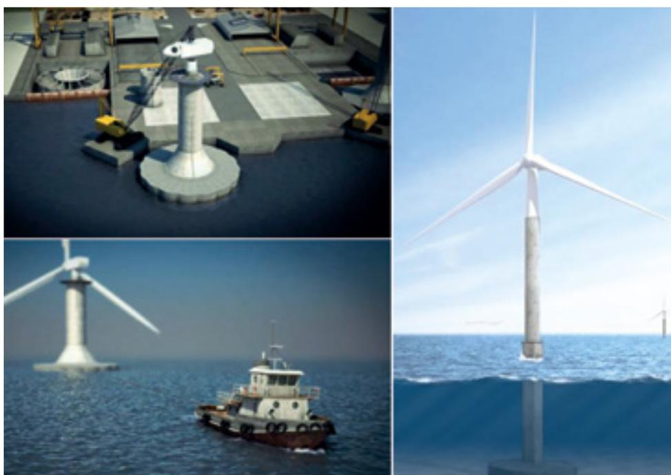
**Figura 3.** Tecnología ELISA. La plataforma de cimentación por gravedad actúa provisionalmente como plataforma flotante que integra una torre telescópica autoelevable. El conjunto puede ensamblarse por completo en puerto junto con el aerogenerador y remolcarse al parque, donde la torre se eleva sin necesidad de grúas o embarcaciones pesadas.
