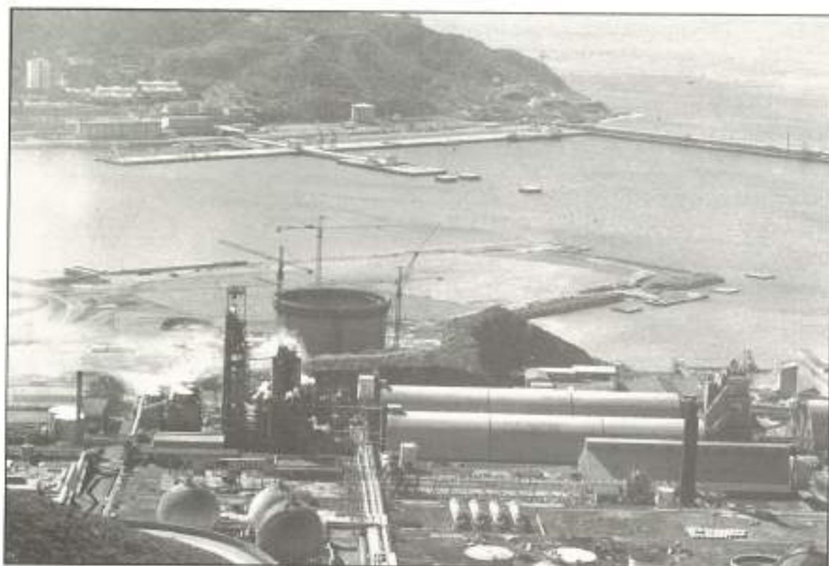
FIGURA 2. Visto del Nuevo Muelle de Granitas (en construcción). (Cortesía de la Junta del Puerto de Cartagena.)
