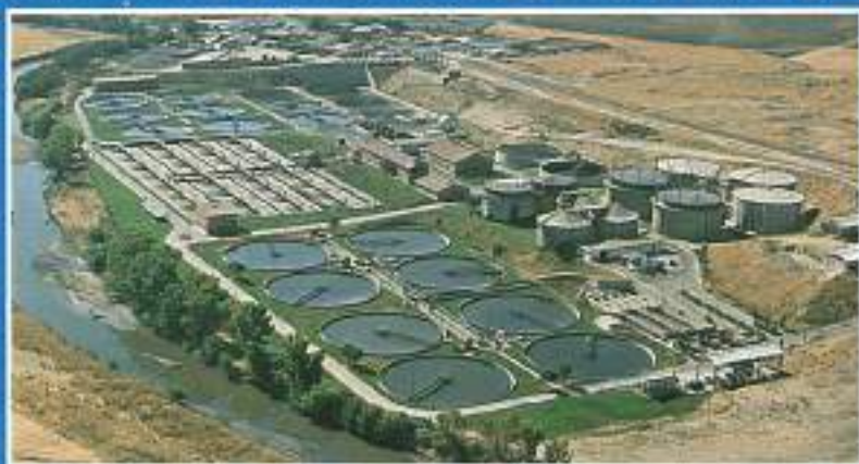
Depuradora de Butarque - Madrid
