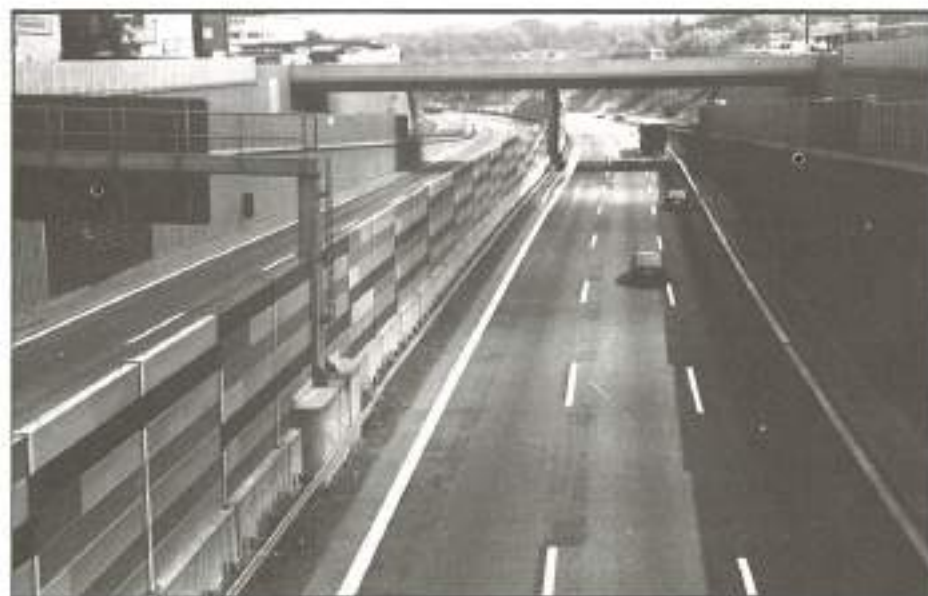
FIGURA 1. Triple sistema de pantallas en autopista.
