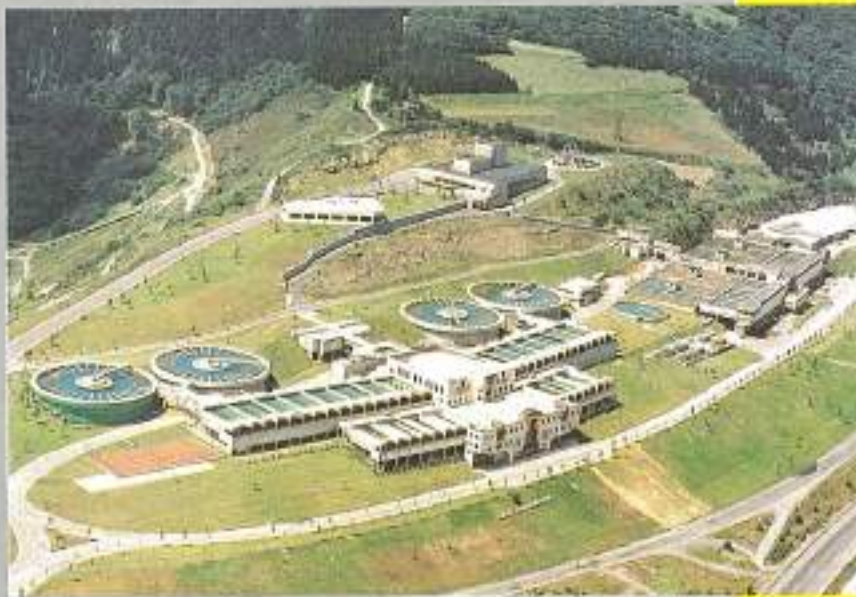
Estación de Tratamiento de Verta Alta (Bilbao).
